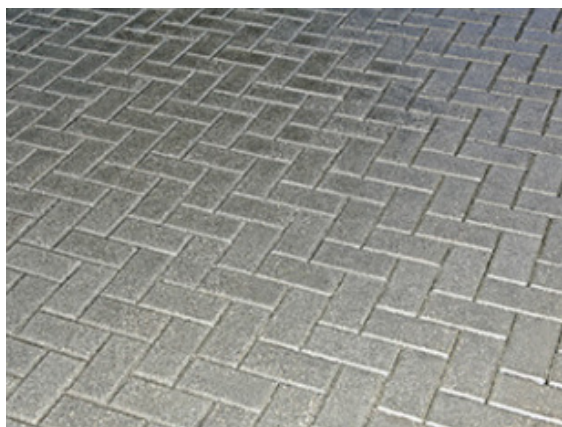
5.att. “Skujiņas” raksts betona bruģakmens segumam
