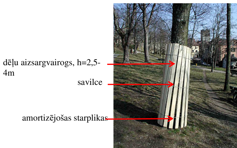
5.attēls. Piemērs koku stumbru aizsardzībai ar dēļu aizsargvairogiem
