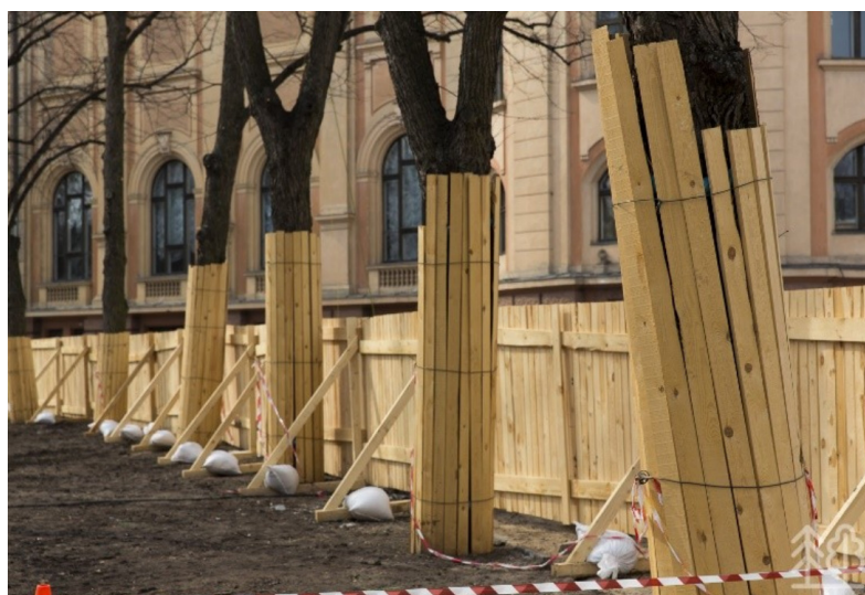
2.attēls. Piemērs koku aizsardzībai būvdarbu laikā
