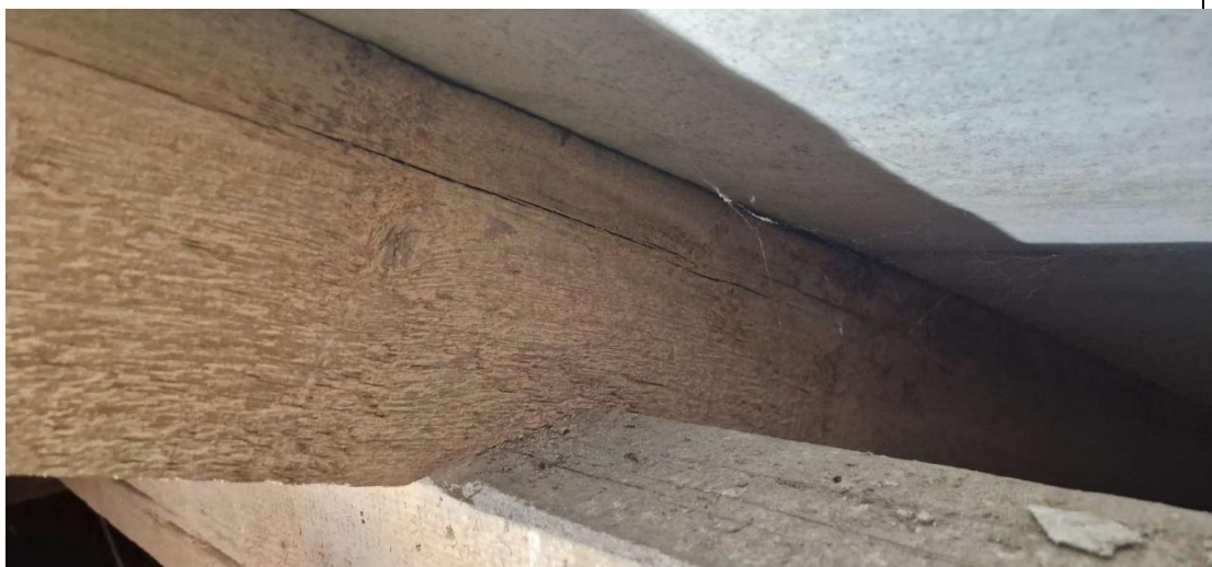
Att.6 spāres balstījums stabils
