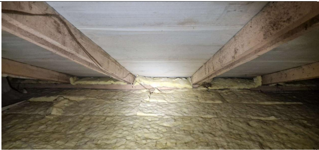
Att.8 spāru balstījums uz mūrlatu
