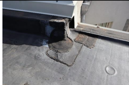
128.att. PVC membrānas iesegums ar pieslēguma vietām
