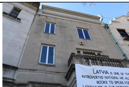
193.att. Ielas fasādes logi
