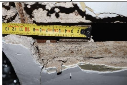
165.att. Atsegums Kāpnēm Nr.1. (110 mm).
