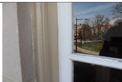
201.att. Balkona koka durvis
