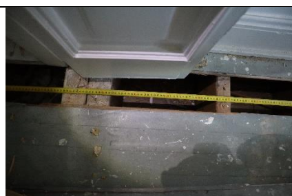
104.att. Atsegums 3.stāva telpās
