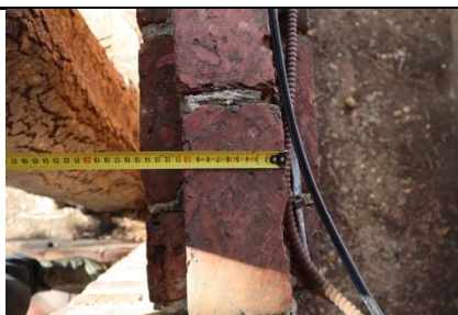
30.att. Nožogojuma biezums (20 cm)
