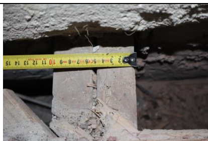
89.att. Pagrabstāva pārseguma siju platums (50mm)
