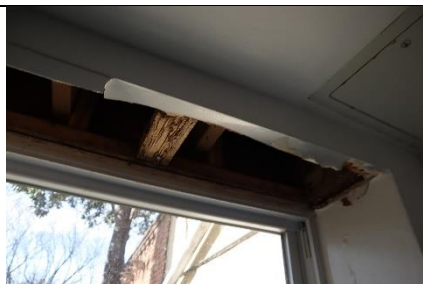
233.att. Bojāta iekšējā apdare ar satrupējušu koksni
