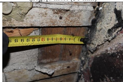
163.att. Atsegums Kāpnēm Nr.1. (105 mm)
