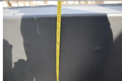
129.att. Parapeta augstums ēkas ZR fasādē (83 cm)
