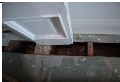
103.att. Atsegums 3.stāva telpās
