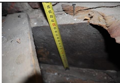
162.att. Podesta koka konstrukcija (200 mm)
