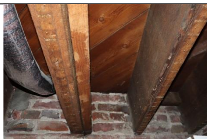
86.att. Pagrabstāva pārseguma sijas
