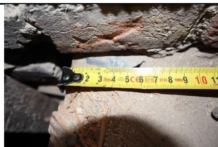
161.att. Podesta koka sijas balsta vieta ķieģeļu mūrī (50 mm)
