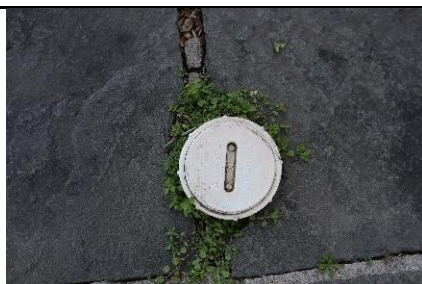
262.att. Kanalizācijas sistēmas kape
