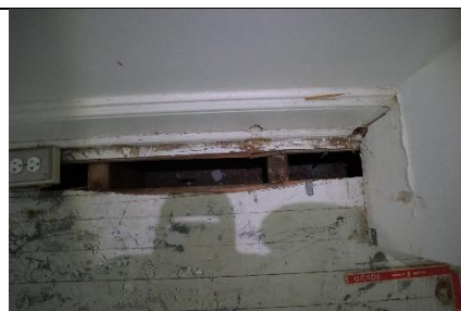
102.att. Atsegums 3.stāva telpās
