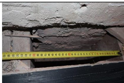
88.att. Pagrabstāva pārseguma siju soli (31 cm)
