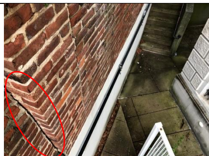
37.att. Plaisa starp ķieģeļu mūra nožogojuma sabiezinājumu
