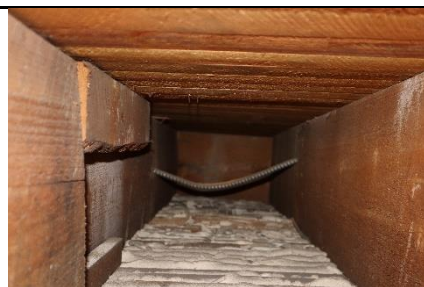
96.att. 3.stāva pārseguma sastāvs
