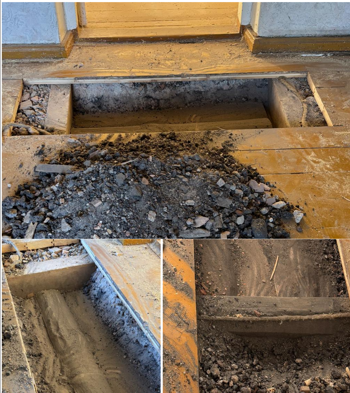
1. stāva pārseguma sijas, atsegtas no 2. stāva telpu grupas
