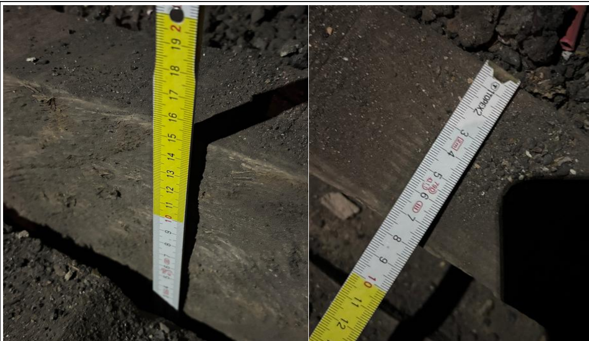
2. stāva pārseguma sijas no bēniņu telpu puses atsegta
