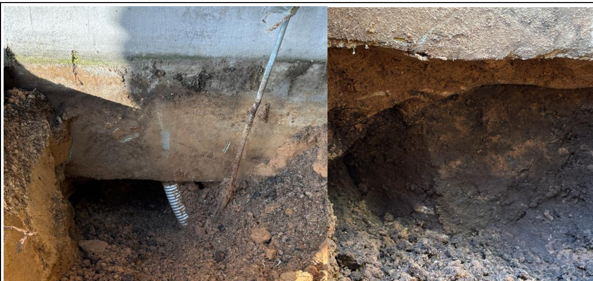
Pamatu atsegums no austrumu fasādes puses, iespējamā vieta lifta konstrukciju izbūvei.
