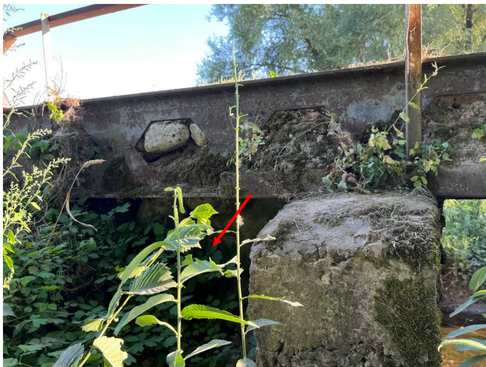
14.att. Tukšums uzbērumā aiz krasta balsta. Skats uz krasta balstu Nr.1 lejtecē.
