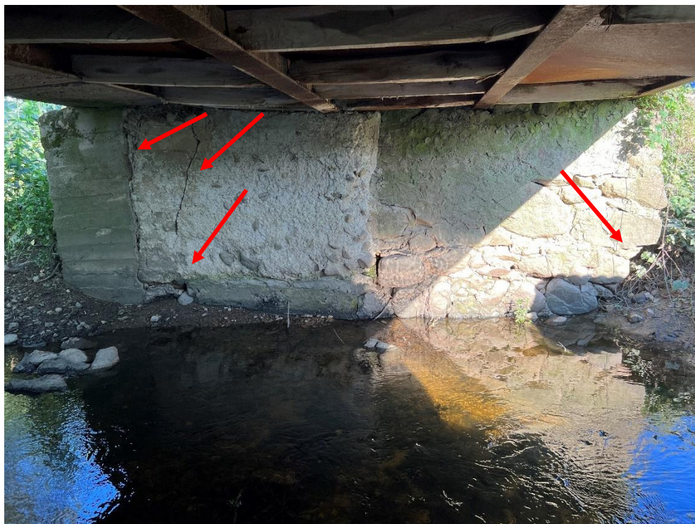
11.att. Plaisas balsta ķermenī, izdrupumi mūrī, sēšanās pazīmes. Skats uz krasta balstu Nr.1.
