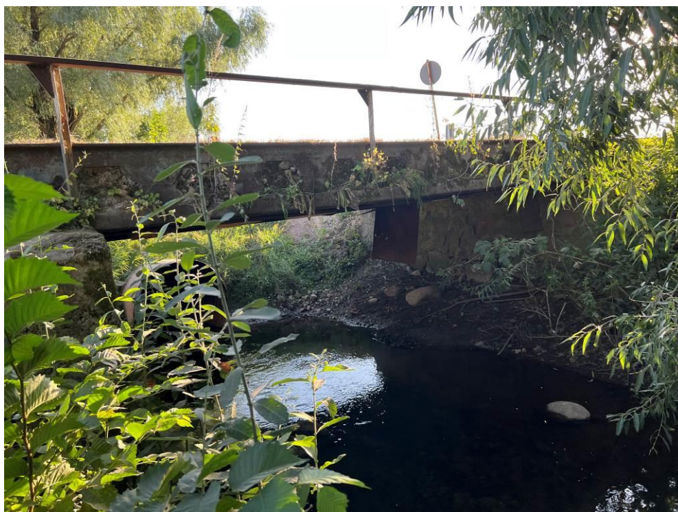
2.att.Tilta sānskats no lejteces puses.
