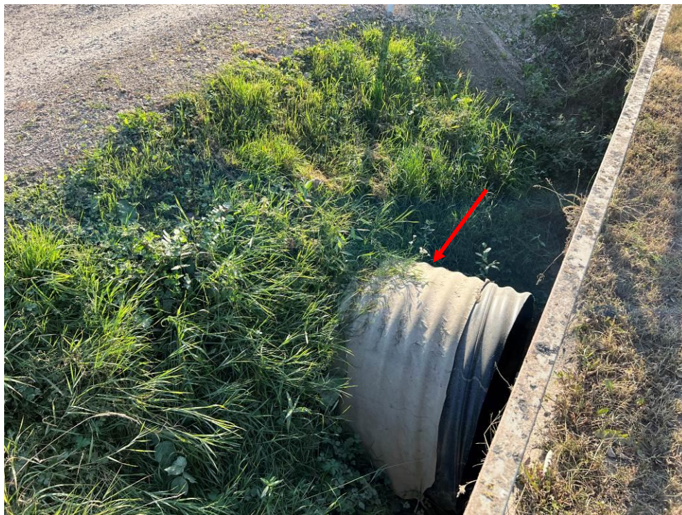
15.att. Izbūvēts apbraucamais ceļā. Skats augšteces pusē.
