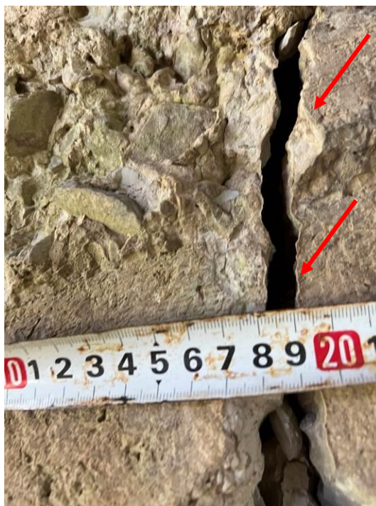
12.att. Plaisas balsta ķermenī 10mm. Skats uz krasta balstu Nr.1.
