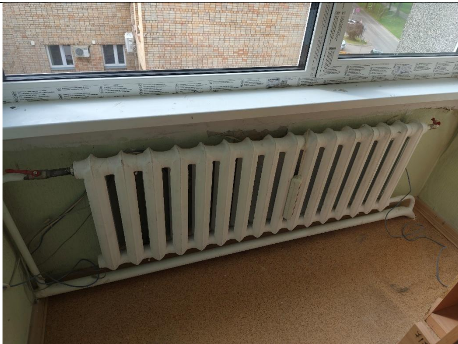
Visā ēkā veca apkures sistēma. Pārsvarā čuguna radiatori.
