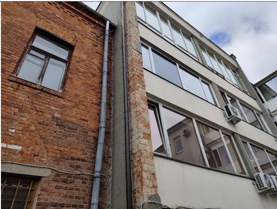
Rīgas ielas 4 Austrumu fasāde, atsegti keramikas ķieģeļi.
