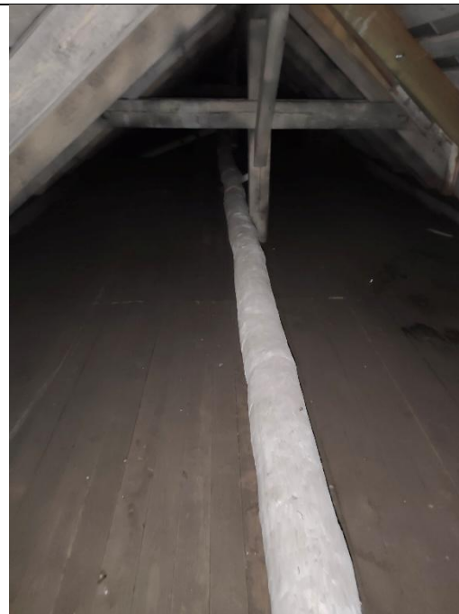
Bēniņos augšējās sadales cauruļvadi. Zem bēniņu grīdas lokāli redzama veca siltumizolācija.
