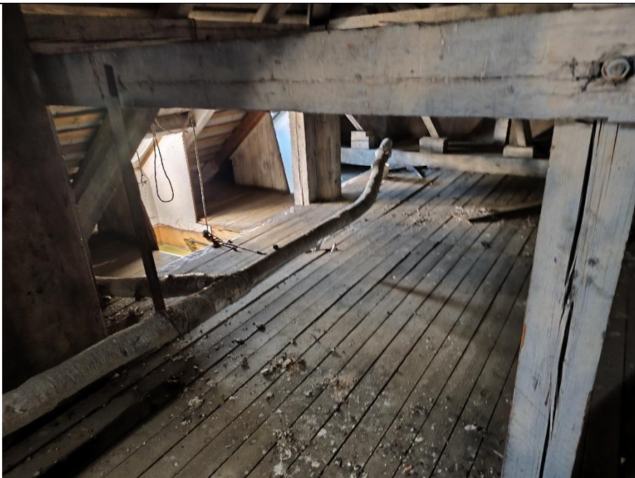
Bēniņos augšējās sadales cauruļvadi. Zem bēniņu grīdas lokāli redzama veca siltumizolācija.
