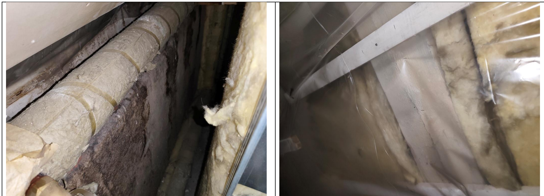
Mansarda stāva pažobeles siltinātas
