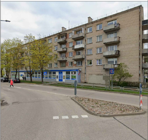
Daudzdzīvokļu dzīvojamā māja Stadionā ielā 2, Daugavpilī (Stadiona ielas fasāde)
