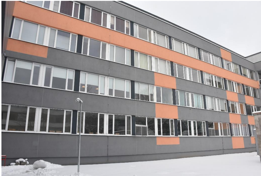
Austrumu puses fasādes.(sk.att.)
