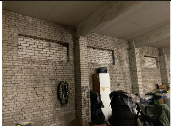
Attēls Nr.4.2.18. 3. sekcijas 5. punkts. Pārsedzes vietā ir divas mazas stiegras.
