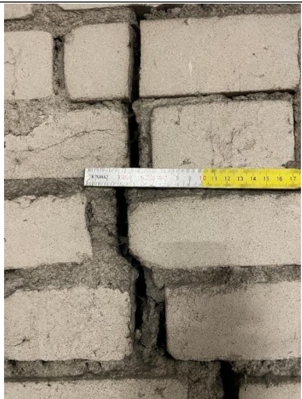
Attēls Nr.4.2.16. 3. sekcijas 3. punkts. Plaša ķieģeļu sienā.
