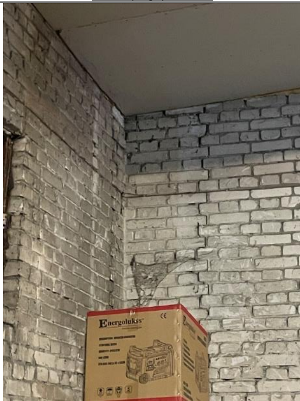
Attēls Nr.4.2.24. 4. sekcijas 4. punkts. Plaisa ķieģeļu sienā.
