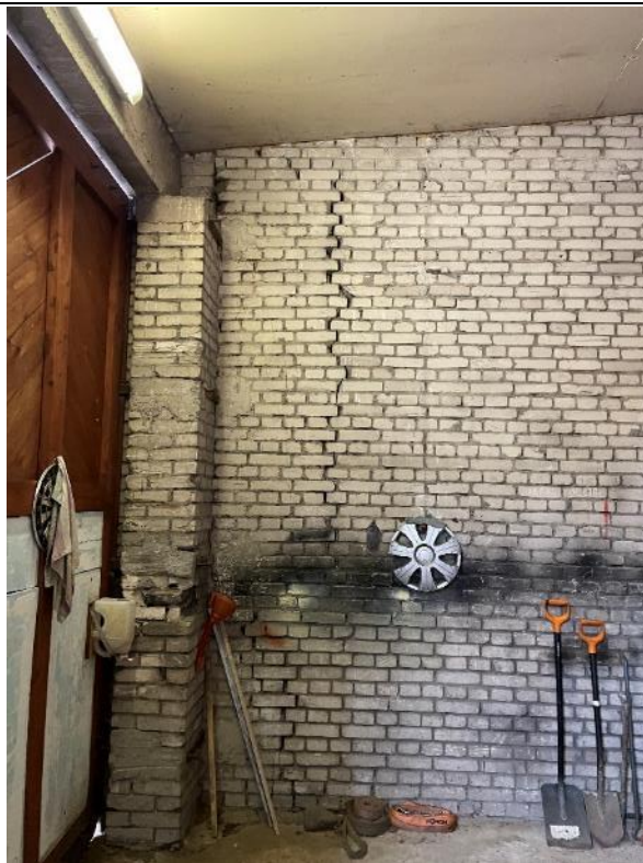
Attēls Nr.4.2.21. 4. sekcijas 1. punkts. Plaisa ķieģeļu sienā.
