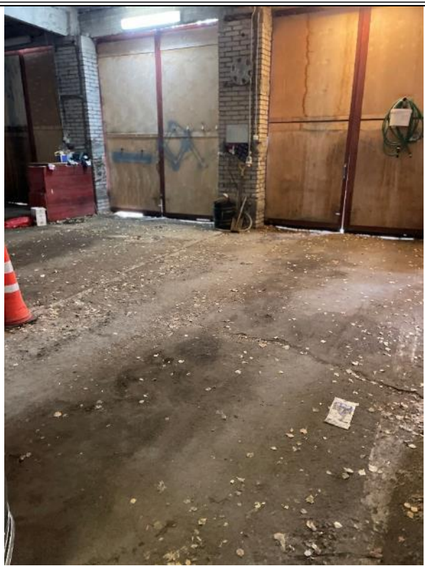
Attēls Nr.4.7.2. Ēkas grīda.
