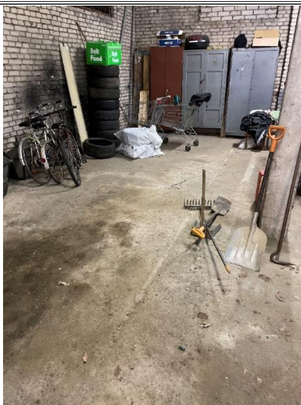
Attēls Nr.4.7.1. Ēkas grīda.
