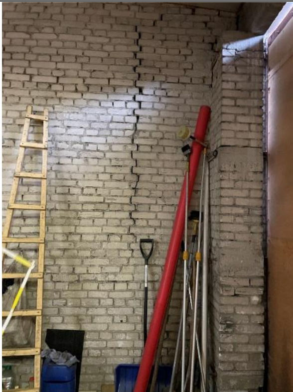
Attēls Nr.4.2.17. 3. sekcijas 4. punkts. Plaša ķieģeļu sienā.
