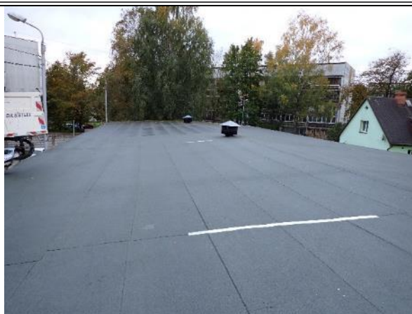
Attēls Nr.4.5.4. Labojuma vietas juma segumā.
