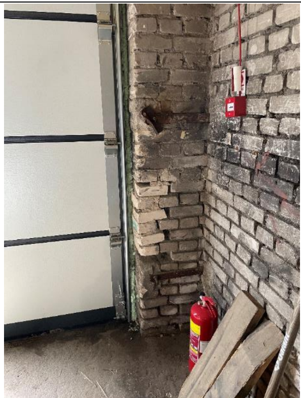
Attēls Nr.4.2.27. 5. sekcijas 1. punkts. Nekvalitatīvs mūrējums.
