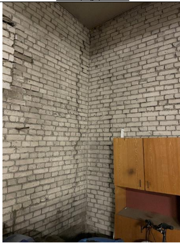
Attēls Nr.4.2.14. 3. sekcijas 2. punkts. Plaša ķieģeļu sienā.
