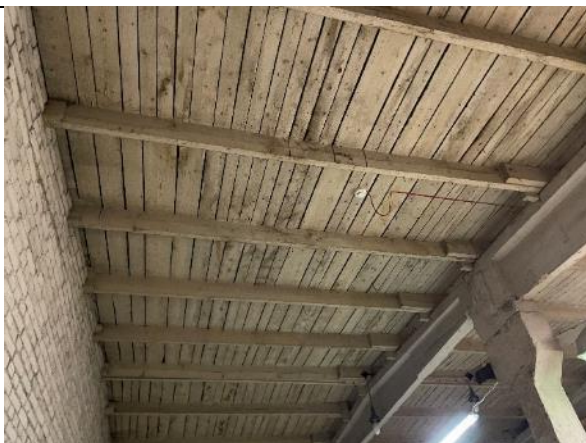
Attēls Nr.4.5.13. Jumta koka sijas un dēļu latojums.
