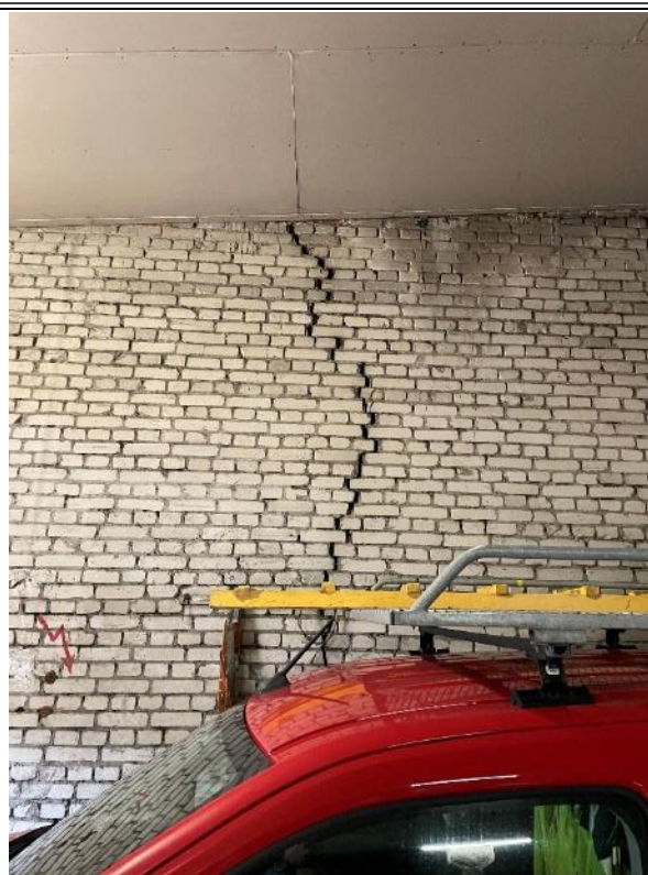
Attēls Nr.4.2.12. 3. sekcijas 1. punkts. Plaša ķieģeļu sienā.
