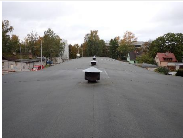
Attēls Nr.4.10.2. Ventilācijas kanāli
