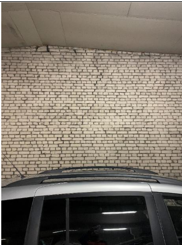
Attēls Nr.4.2.9. 2. sekcijas 3. punkts. Plaisa ķieģeļu sienā.
