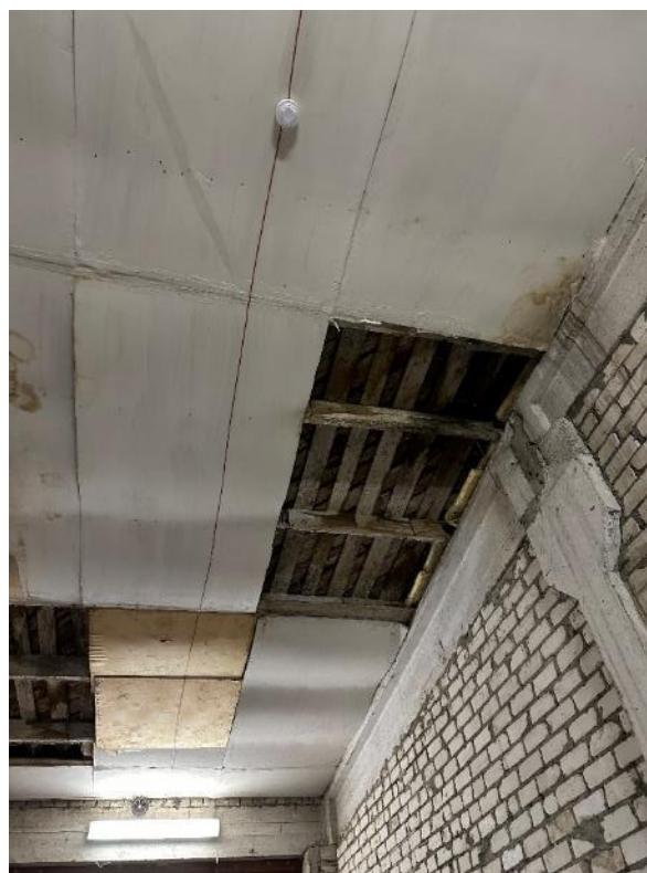
Attēls Nr.4.5.14. Izpuvis jumta latojums.
