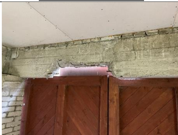
Attēls Nr.4.2.32. 7. sekcijas 3. punkts. Izcirtums dz/b pārsedzē.
