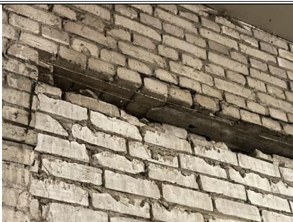
Attēls Nr.4.2.19. 3. sekcijas 5. punkts. Pārsedze vietā ir divas mazas stiegras.
