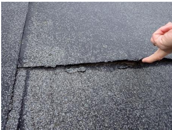
Attēls Nr.4.5.3. Nekvalitatīvi sakausēts savstarpēji jumta segums.
