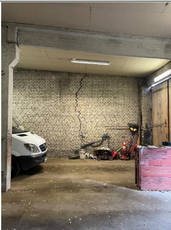
Attēls Nr.4.2.7. 2. sekcijas 1. punkts. Plaisa ķieģeļu sienā.
