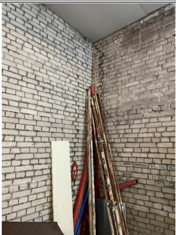
Attēls Nr.4.2.23. 4. sekcijas 3. punkts. Plaisa ķieģeļu sienā.
