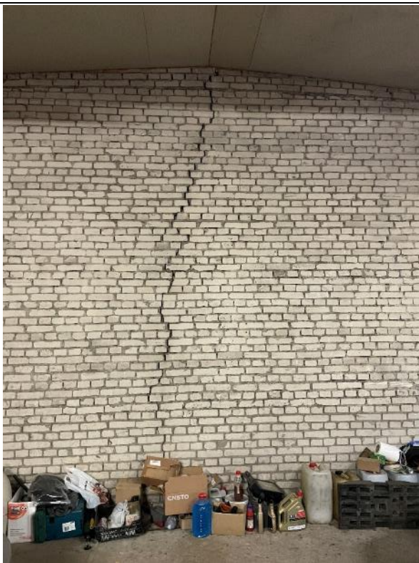
Attēls Nr.4.2.15. 3. sekcijas 3. punkts. Plaša ķieģeļu sienā.
