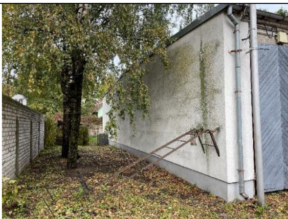
Attēls Nr.4.11.2. Ēkas siltinājums.
