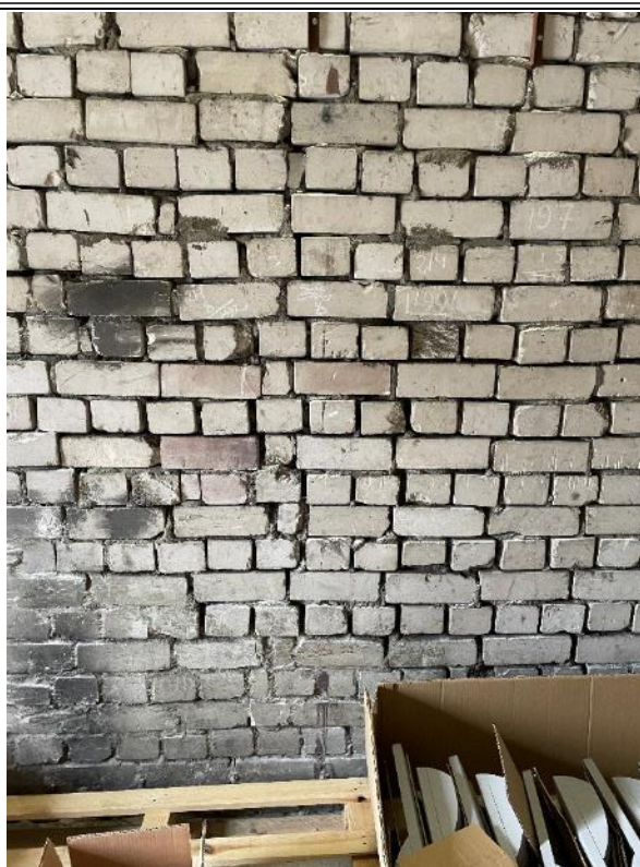
Attēls Nr.4.2.30. 6. sekcijas 1. punkts. Nekvalitatīvi uzmūrēta siena.
