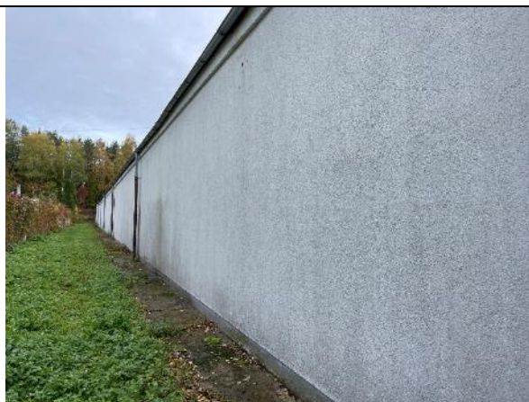
Attēls Nr.4.11.3. Ēkas siltinājums.
