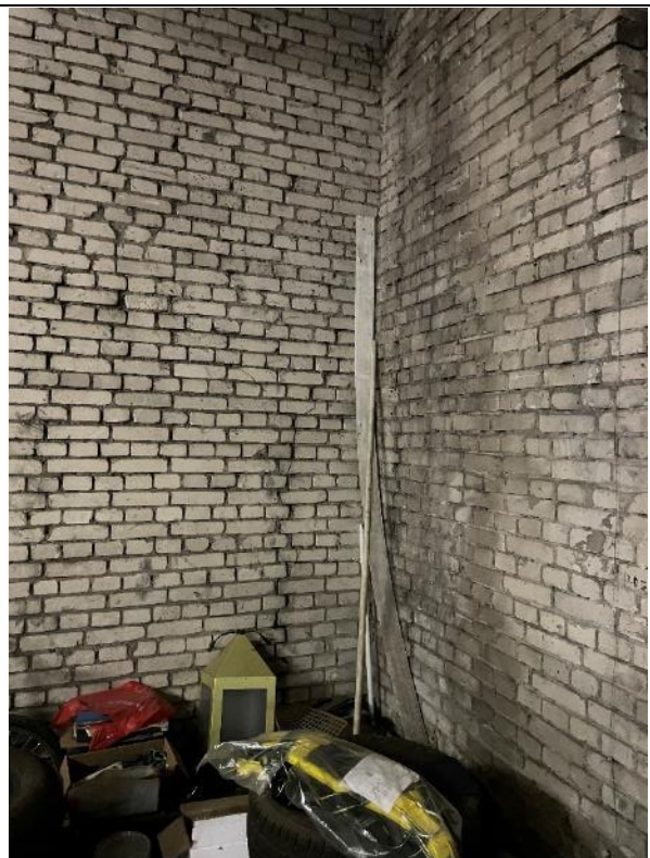
Attēls Nr.4.2.10. 2. sekcijas 4. punkts. Plaisa ķieģeļu sienā.
