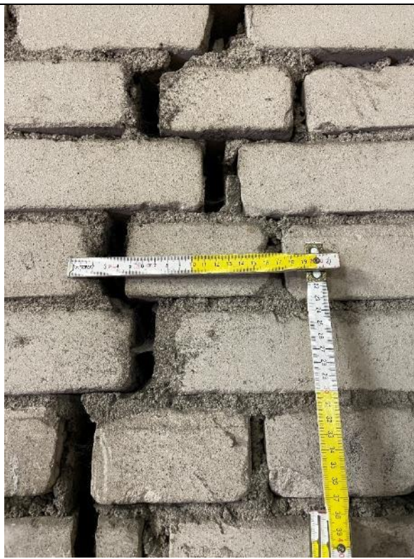
Attēls Nr.4.2.13. 3. sekcijas 1. punkts. Plaša ķieģeļu sienā.
