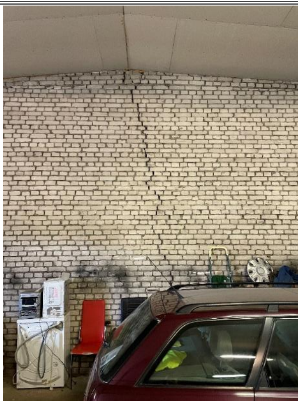
Attēls Nr.4.2.22. 4. sekcijas 2. punkts. Plaisa ķieģeļu sienā.
