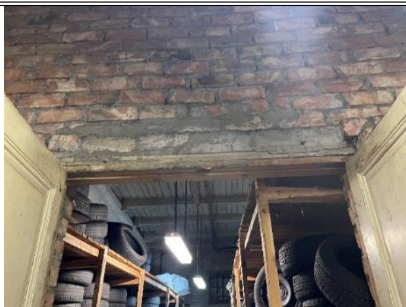
Attēls Nr.4.2.14. 8. sekcijas 2. punkts. Koka pārsedze.
