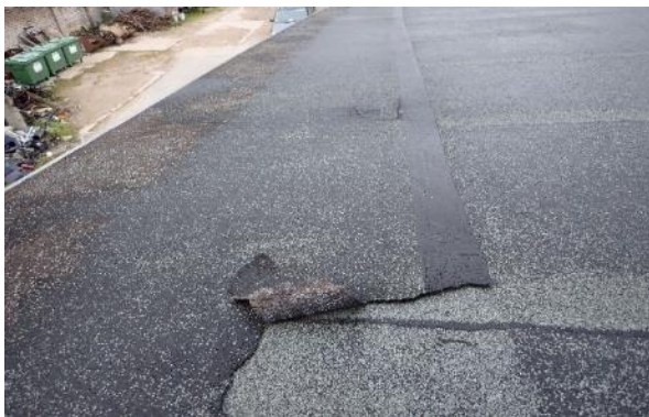
Attēls Nr.4.5.3. Nekvalitatīvi sakausēts savstarpēji jumta segums.
