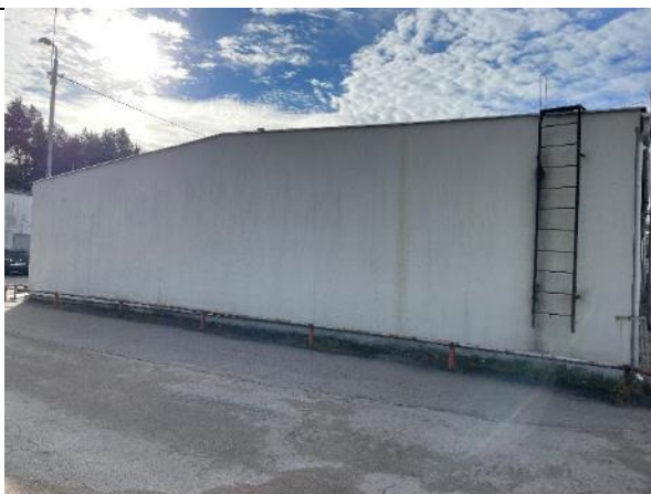
Attēls Nr.4.10.2. Ēkas siltinājums.
