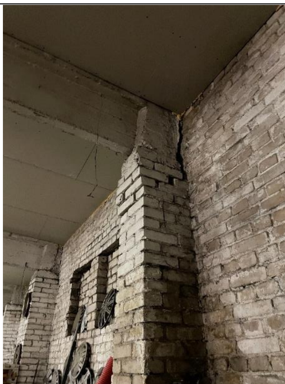
Attēls Nr.4.3.4. 1. sekcijas 2. punkts. Dz/b sijas balstījums.
