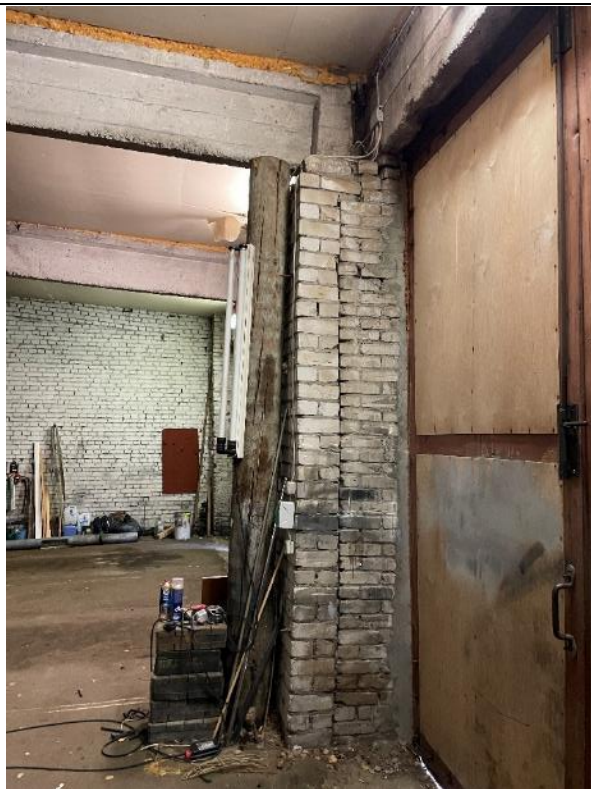
Attēls Nr.4.3.7. 2. sekcijas 1. punkts. Kieģeļu kolonna.
