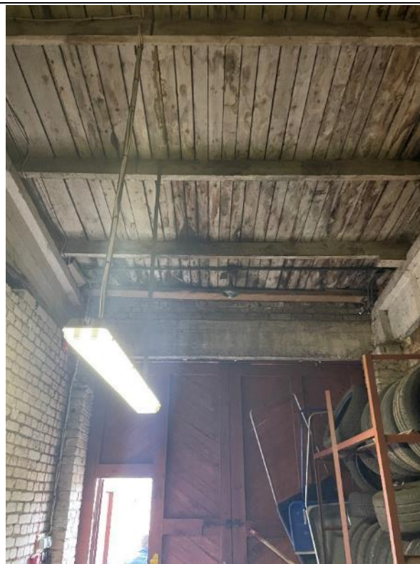
Attēls Nr.4.5.12. Jumta koka sijas un dēļu latojums.
