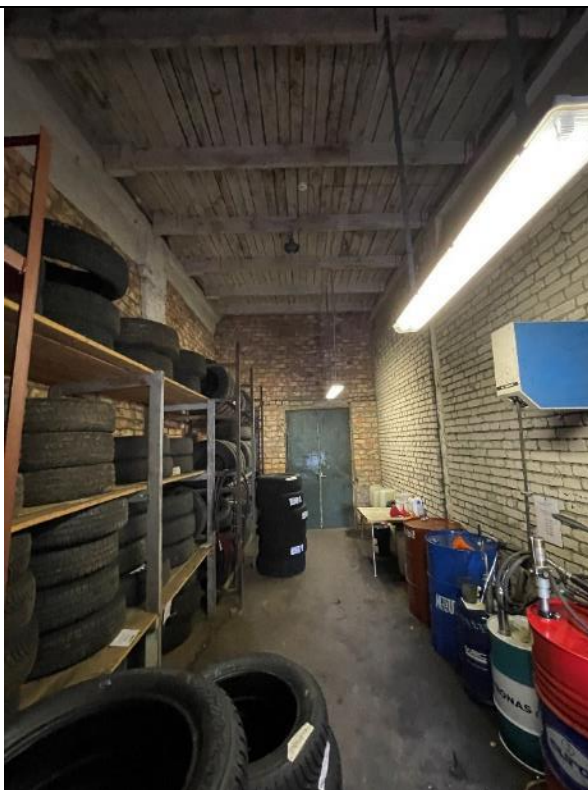
Attēls Nr.4.5.13. Jumta koka sijas un dēļu latojums.
