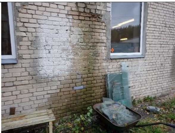
Attēls Nr.4.5.9. Ūdens un sala rezultātā, bojāta ēkas siena.
