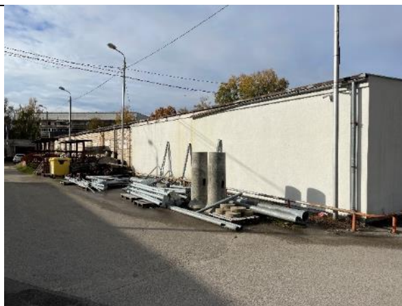
Attēls Nr.4.10.3. Ēkas siltinājums.
