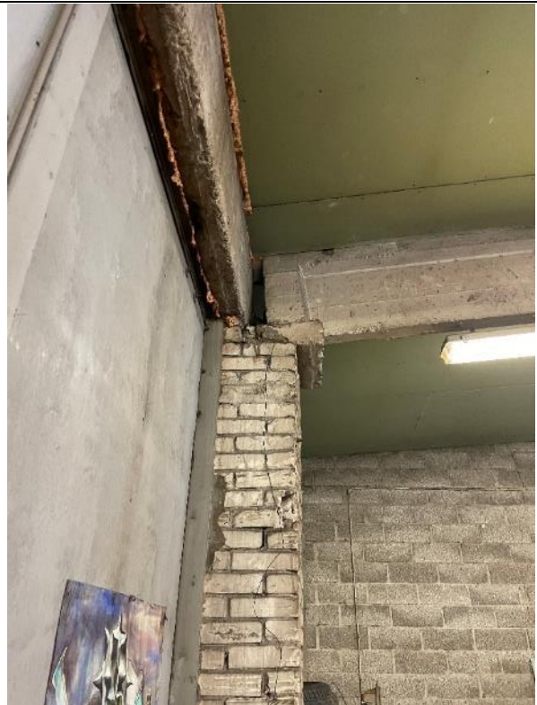
Attēls Nr.4.3.16 5. sekcijas 1. punkts. D/z b sijas balstījums
