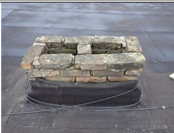
Attēls Nr.4.5.7. Mūreta ventilācijas šahta.
