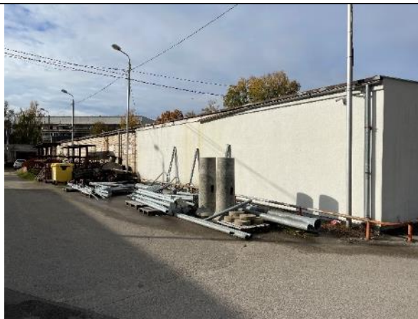
Attēls Nr.3.1.2. Teritorijas labiekārtojums pie ēkas aizmugures daļas
