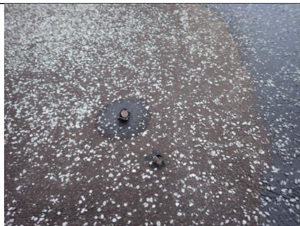
Attēls Nr.4.5.2. Ar naglām caurumots jumta segums.
