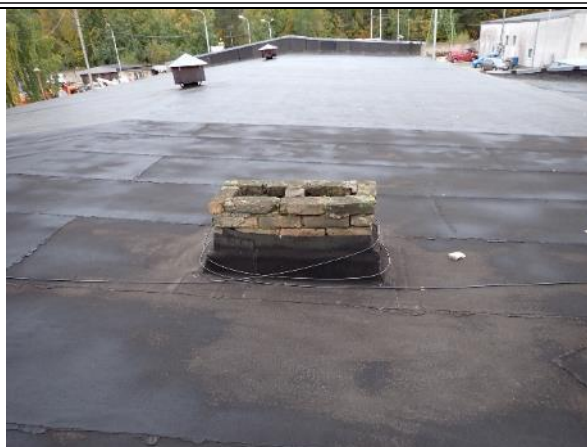
Attēls Nr.4.9.2. Ventilācijas kanāli
