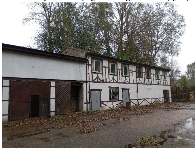
3.1.1.att. asfaltbetona segums pagalmā
