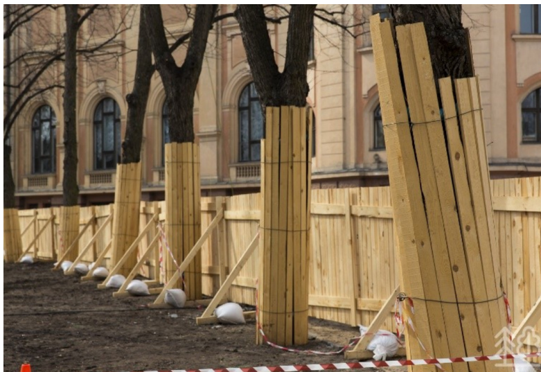
2.attēls. Piemērs koku aizsardzībai būvdarbu laikā
