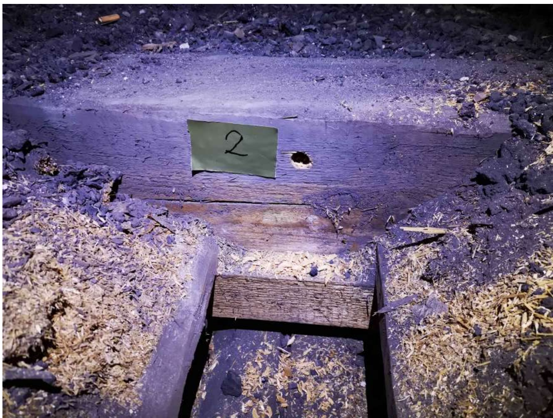
44.fotoattēls Kontrolurbums 2.stāva pārseguma sijā.
