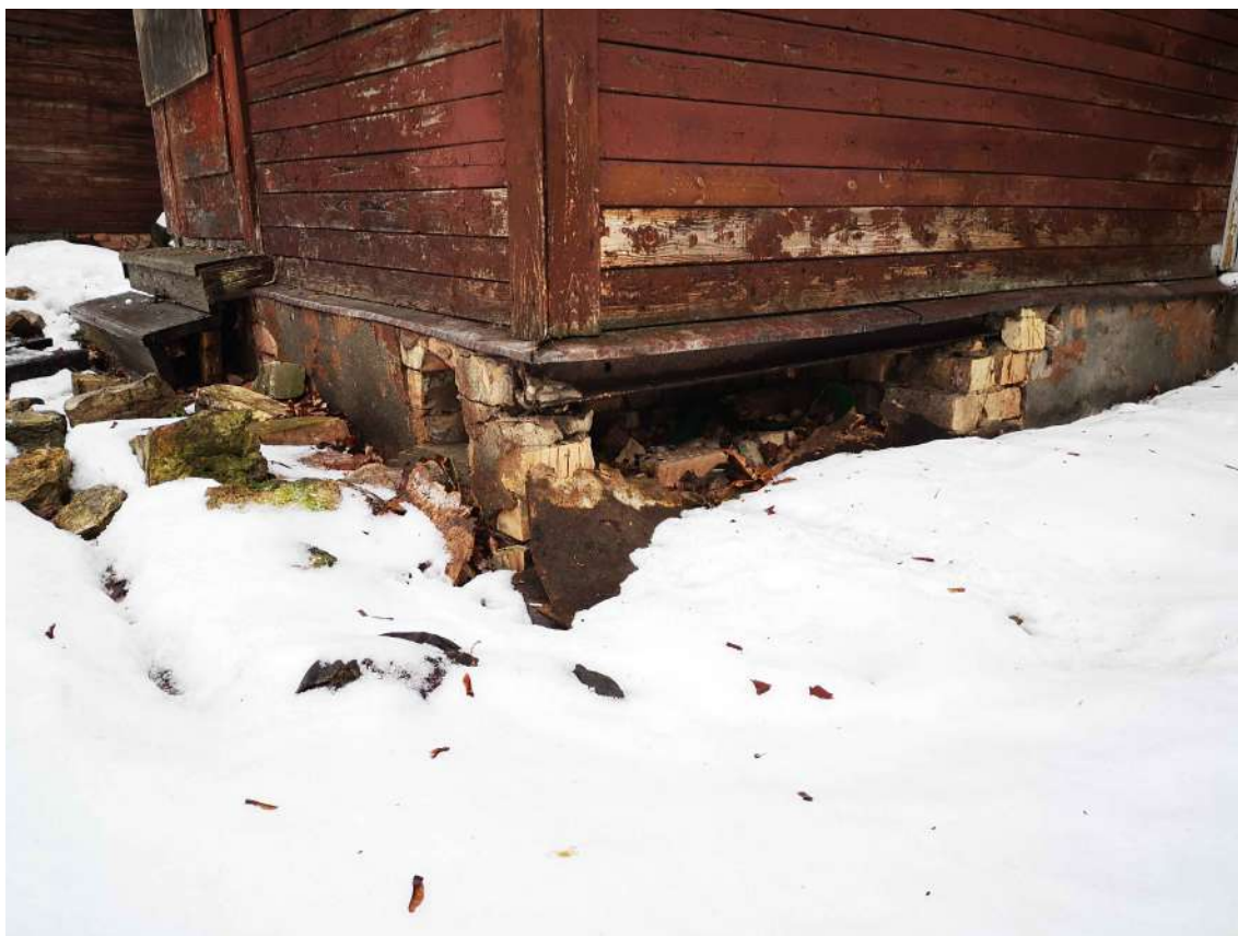
49.fotoattēls Erodējuši pagalma piebūves virspamati.
