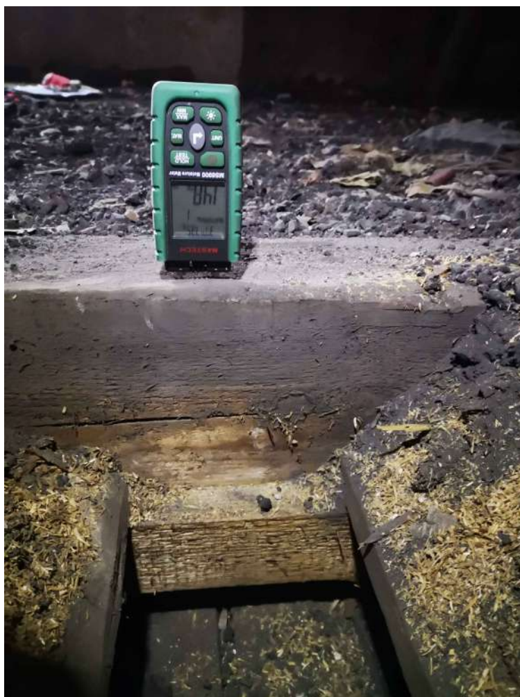
42.fotoattēls 2.stāva pārseguma pīrāga atsegums.
