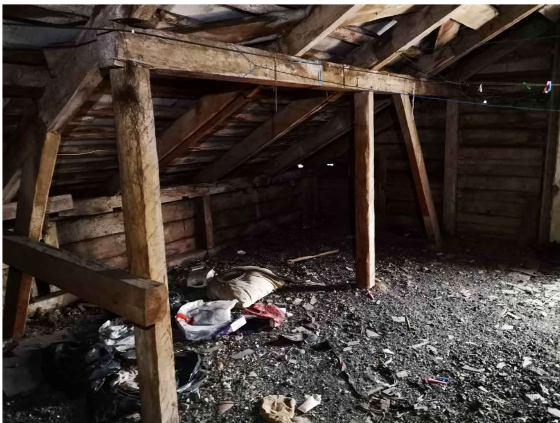
34.fotoattēls Taisnais jumta krēsls ēkas galos ar stinguma atgāžņiem.
