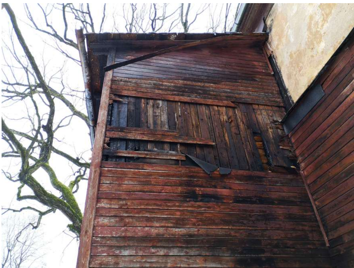
48.fotoattēls Satrupējuši un atdalījušies pagalma piebūves apdares elementi.
