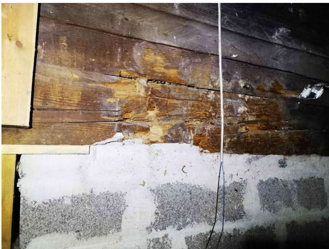
20.fotoattēls Lokāli nomainīts nesošās iekšsienas posms.
