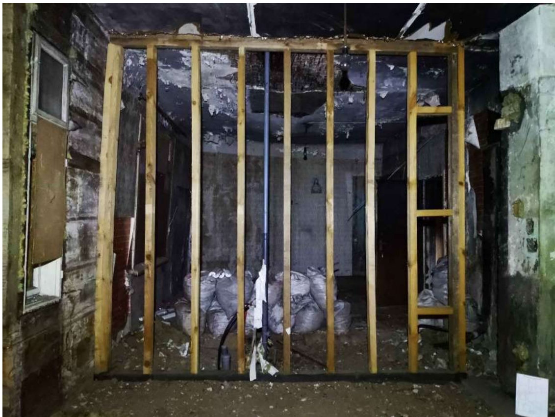
24.fotoattēls Pagaidu konstrukcija telpā T114.
