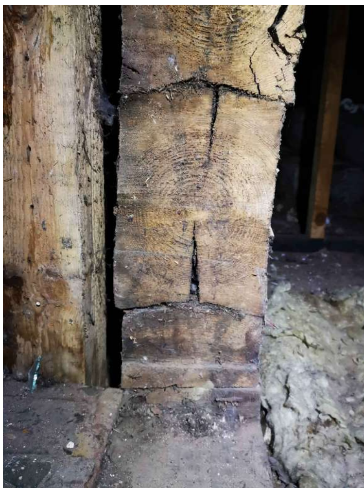
26.fotoattēls Ārsienas apakšējais balstmezgls.
