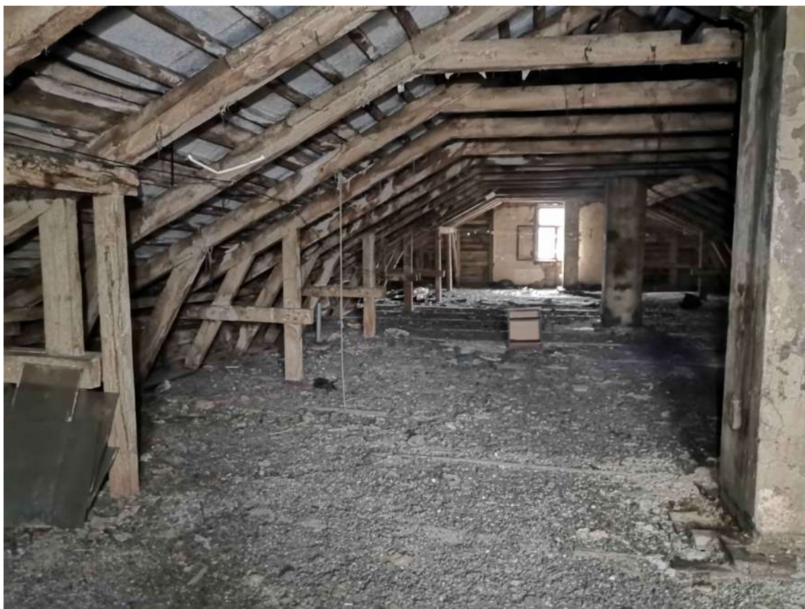
31.fotoattēls Jumta konstrukciju kopskats.
