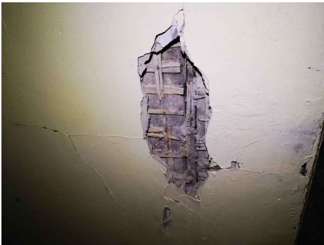
39.fotoattēls Nesošo iekšsienu konstrukcijas atsegumi 2.stāvā.
