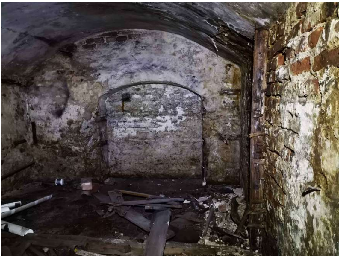
13.fotoattēls Erodējušas pagraba sienu un pārseguma mūra virsmas.
