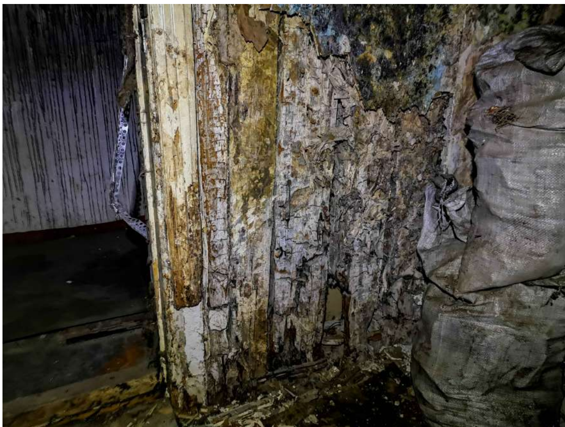
19.fotoattēls Pilnībā satrupējis nesošo iekšsienu posms.
