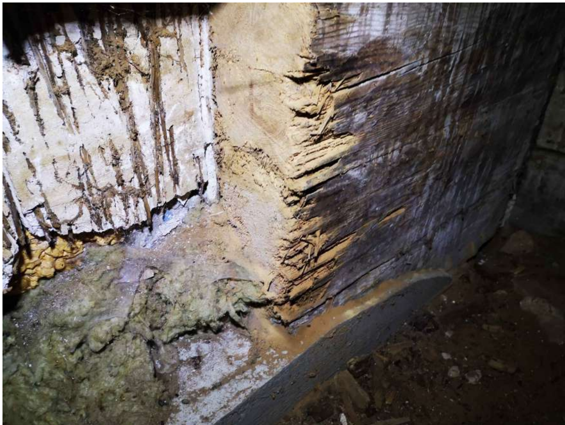
23.fotoattēls Lokāli satrupējis nesošās iekšsienas posms.
