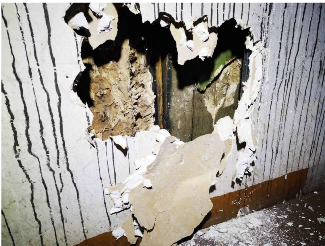
12.fotoattēls Nesošo starpsienu konstrukcijas atsegumi.
