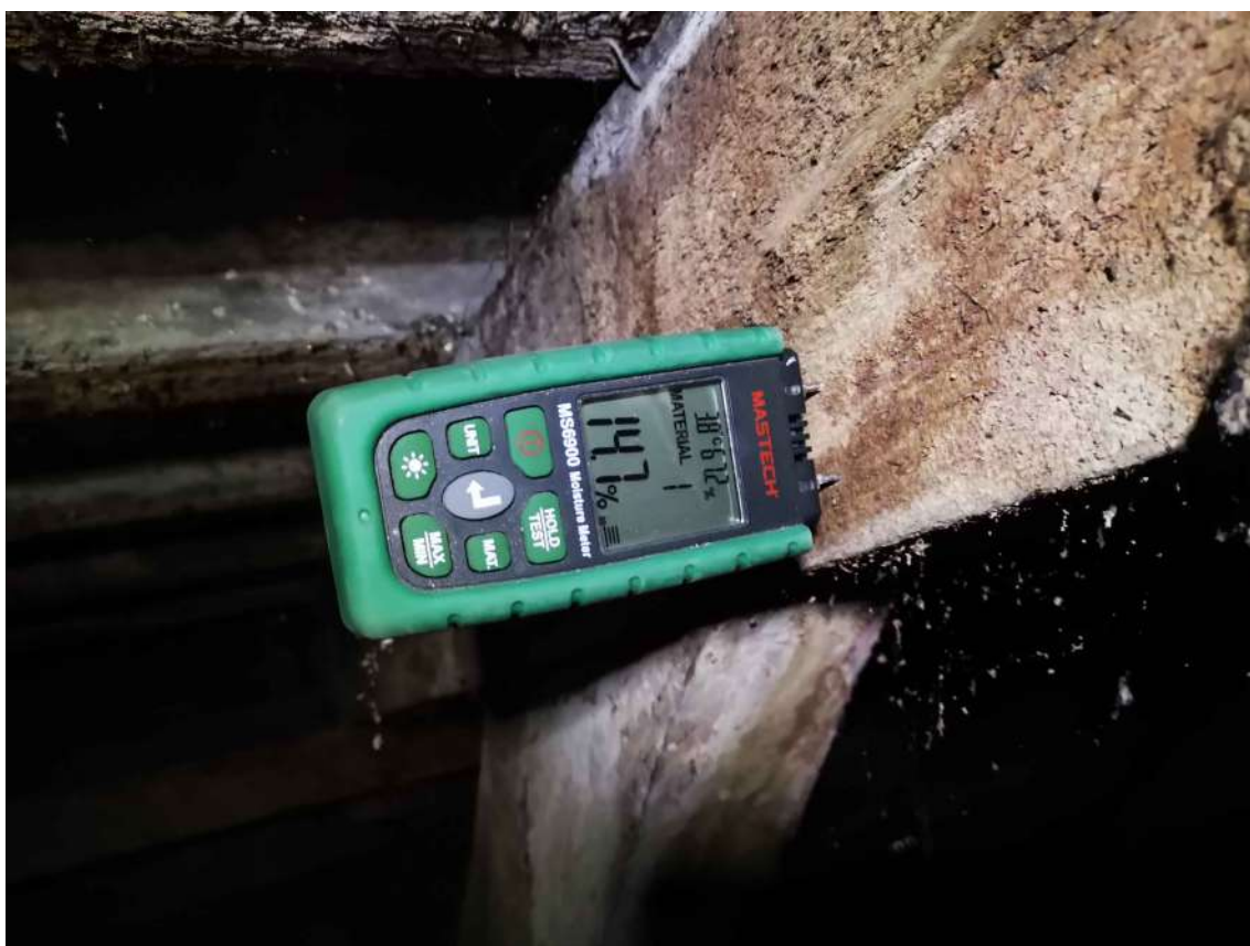
40.fotoattēls Nesošo jumta elementu mitruma mērījumi.
