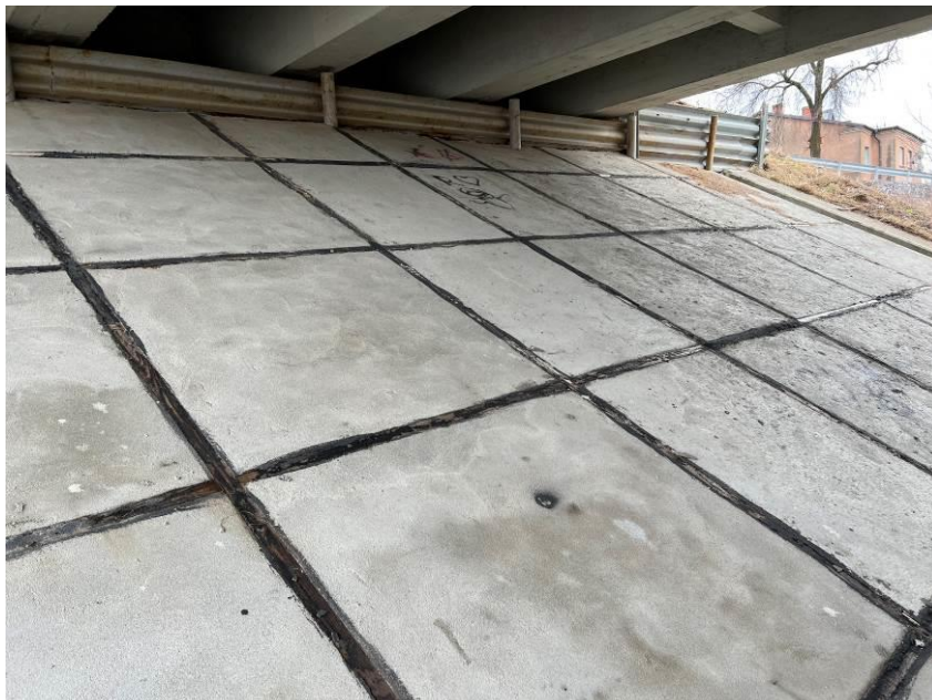
17.att. Skats uz konusa nostiprinājumu pie krasta balsta Nr.1.
