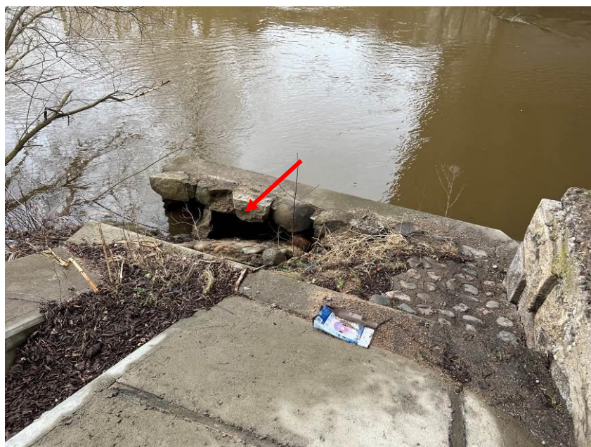
20.att. Veidojas izskalojums upes balsta nostiprinājumā. Skats pie upes balsta Nr.2.
