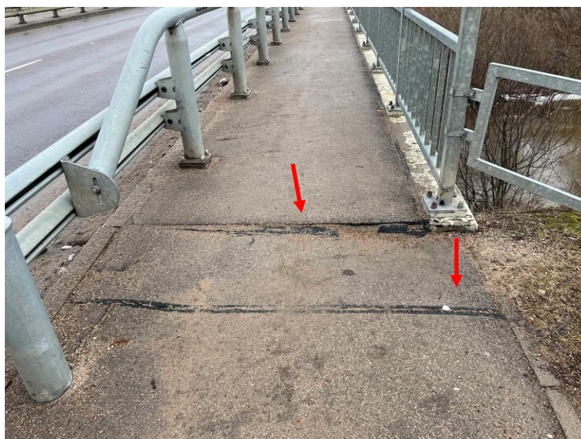
6.att. Iesēdums segumā ietves pieejā. Skats pie krasta balsta Nr.4 augštes pusē.
