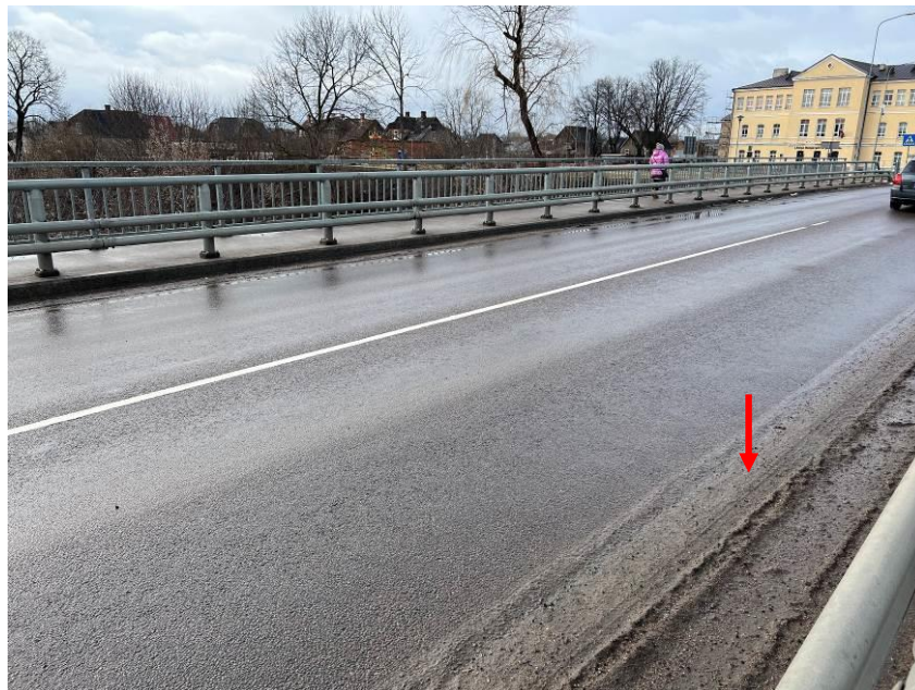
3.att. Sanesumi brauktuves malās. Skats uz brauktuves segumu no krasta balsta Nr.1 puses.
