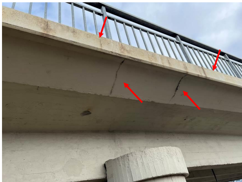
13.att. Regulāras matveida plaisas ietves konsolē un karnīzē. Skats virs upes balsta Nr.3 augšteces pusē.
