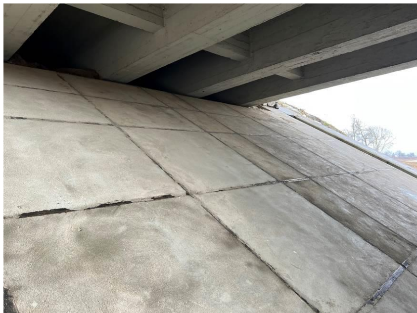
23.att. Skats uz konusa nostiprinājumu pie krasta balsta Nr.4.
