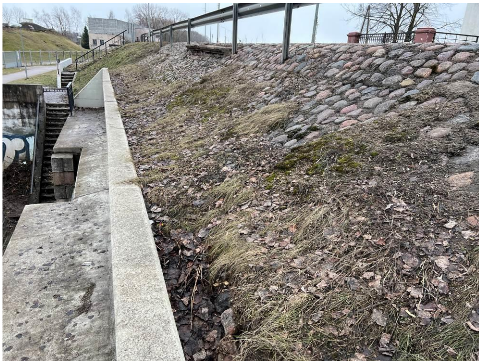
8.att. Skats uz uzbēruma nostiprinājumu ieteces pusē.
