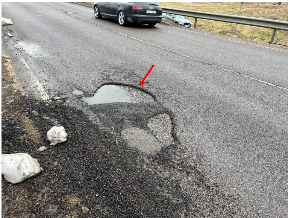
4.att. Nolietojies brauktuves segums, veidojas bedres Skats lejtecies pusē.
