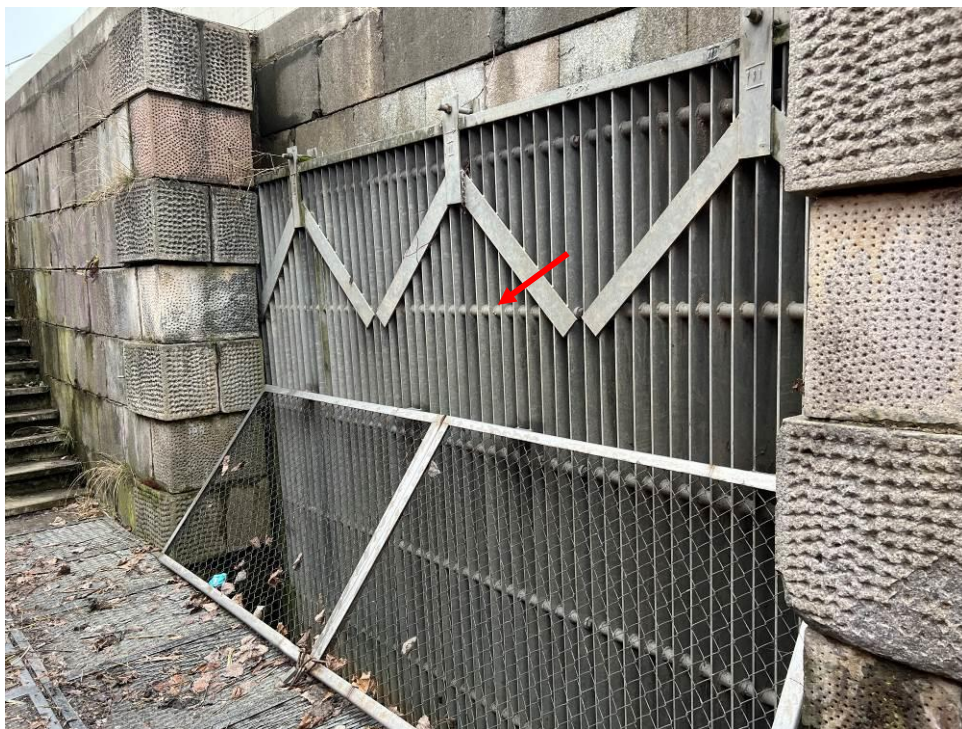
9.att. Slēgta velves konstrukcija. Skats augšteces pusē.
