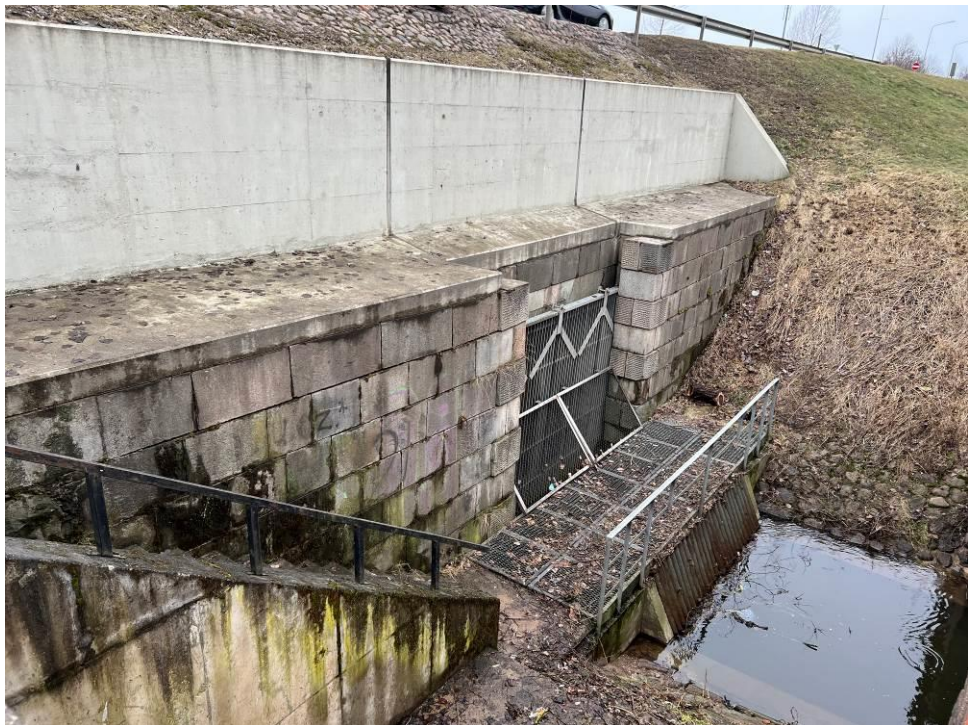
2.att. Tilta sānskats no augšteces puses.
