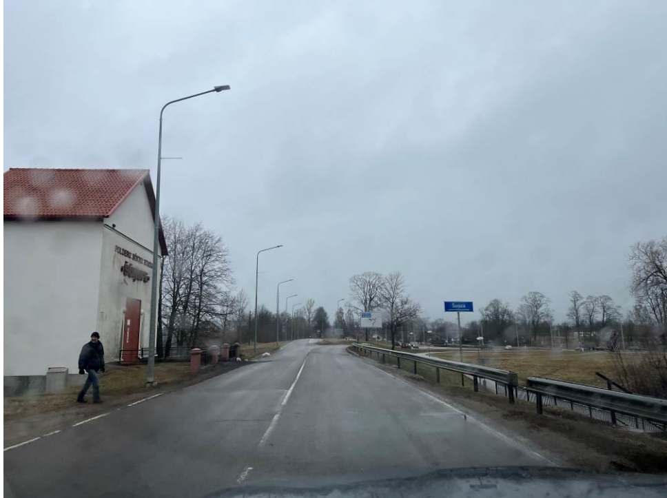
1.att. Tilta brauktuve.
