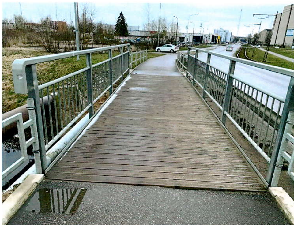
13.att. Gājēju tilts. Skats augšteces pusē.
