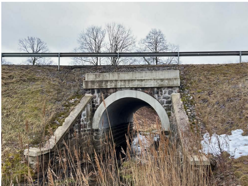
2.att. Tilta sānskats no augšteces puses.
