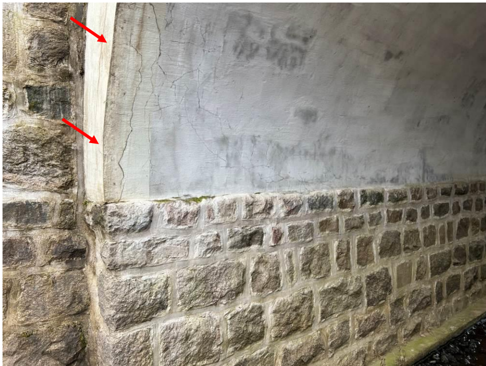
7.att. Slikta ūdens atvades rezultāta bojājumi ķieģeļu velves apmetumā. Skats augšteces pusē pie krasta balsta Nr.2.
