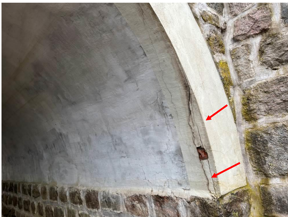
6.att. Slikta ūdens atvades rezultāta bojājumi ķieģeļu velves apmetumā. Skats augšteces pusē pie krasta balsta Nr.1.
