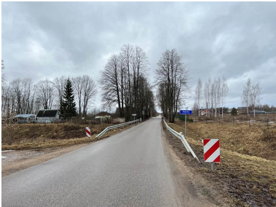
1.att. Tilta brauktuve.
