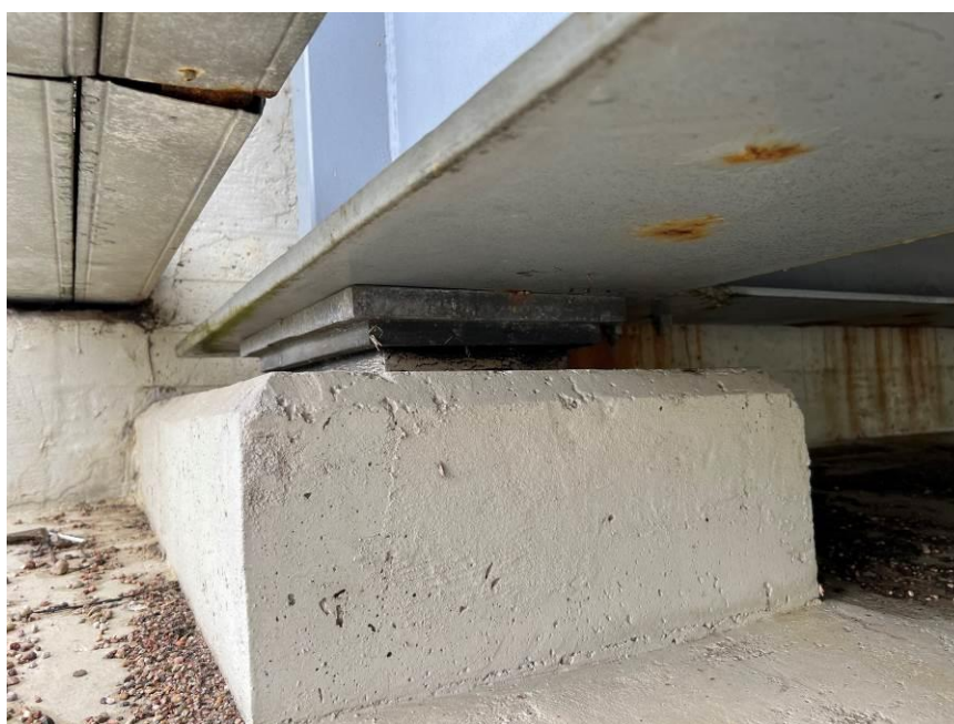
20.att. Skats uz balstīklām virs krasta balsta Nr.1.
