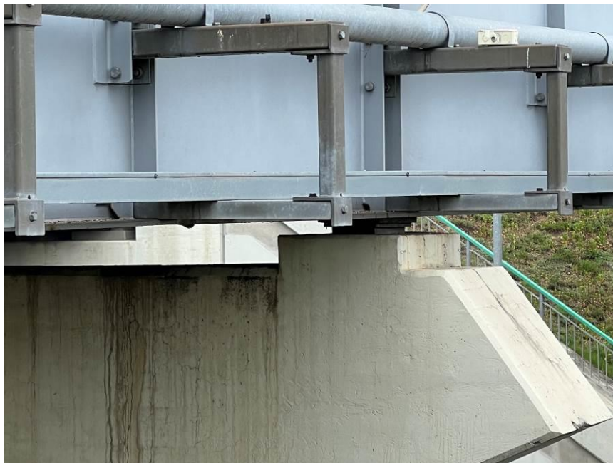
23.att. Skats uz balstīklām virs starpbalsta Nr.2.
