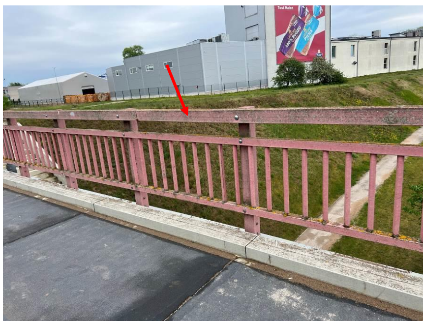
8.att Izbalējis un apaudzis margu krāsojums. Skats uz tilta margām (Piekrastes ielas puse).
