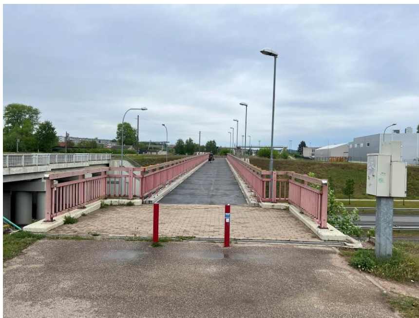
1.att. Tilta brauktuve no Andreja Pumpura ielas puses.
