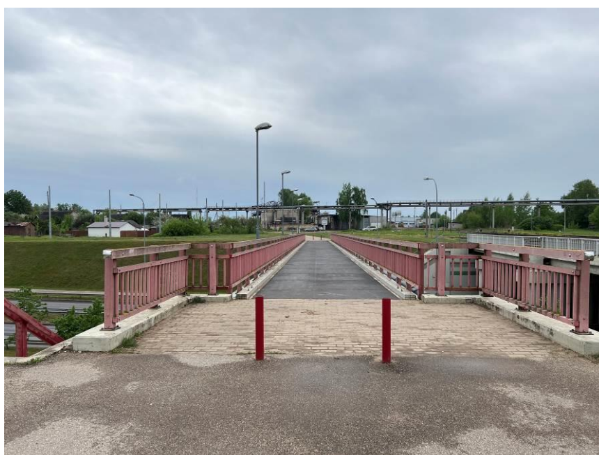
2.att. Tilta brauktuve no Slāvu ielas puses.
