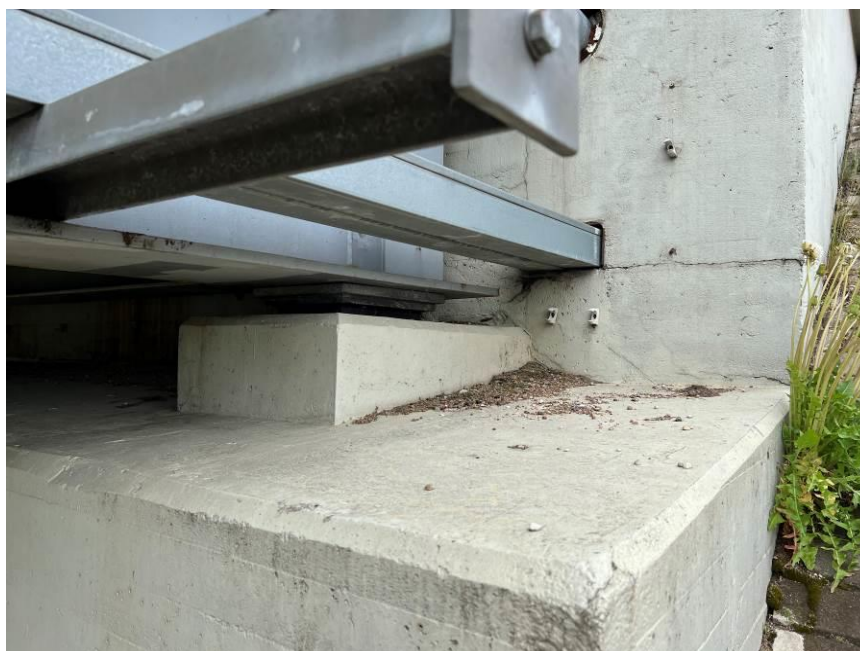
28.att. Skats uz balstīklām virs krasta balsta Nr.1.
