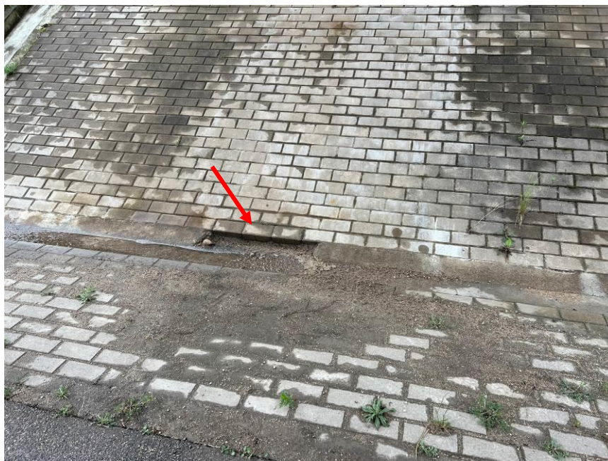
21.att. Bojāts konusa nostiprinājums. Skats pie krasta balsta Nr.1.
