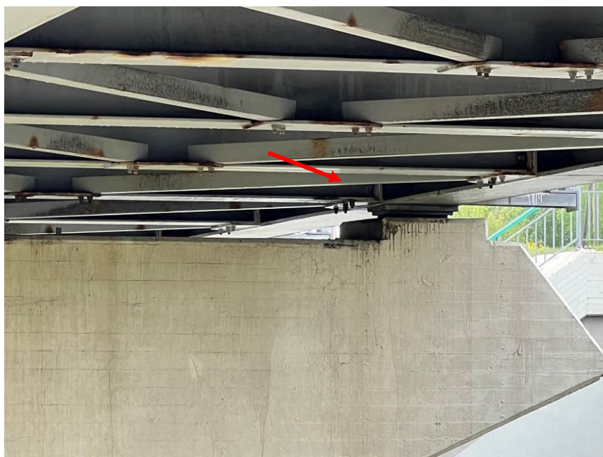
26.att. Skats uz balstīklām virs starpbalsta Nr.3.
