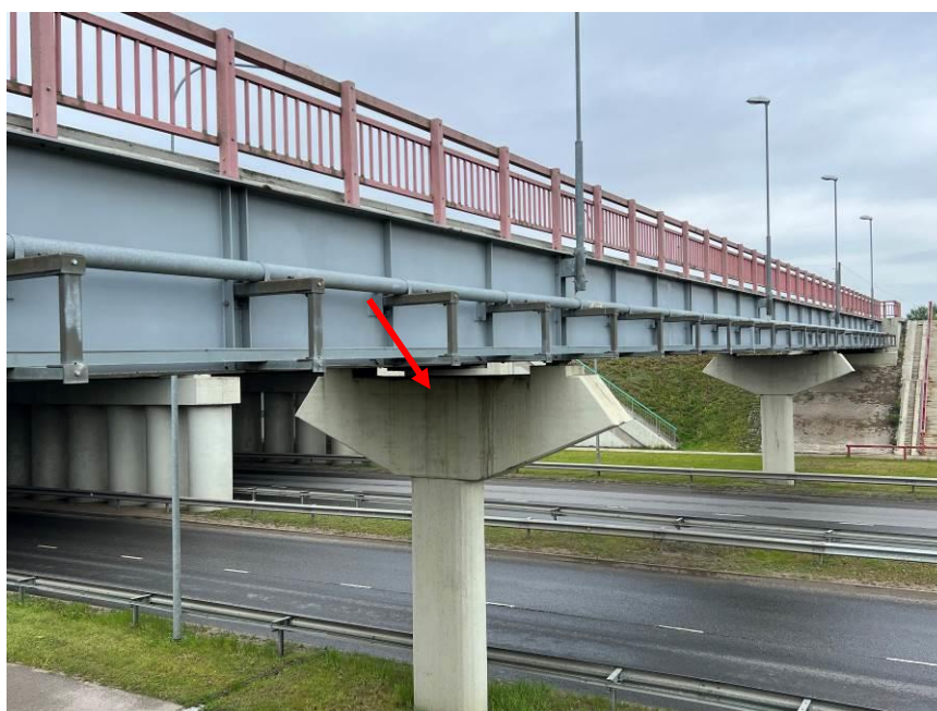
22.att. Ūdens notecējumi uz uzkalas. Skats uz starpbalstu Nr.2.
