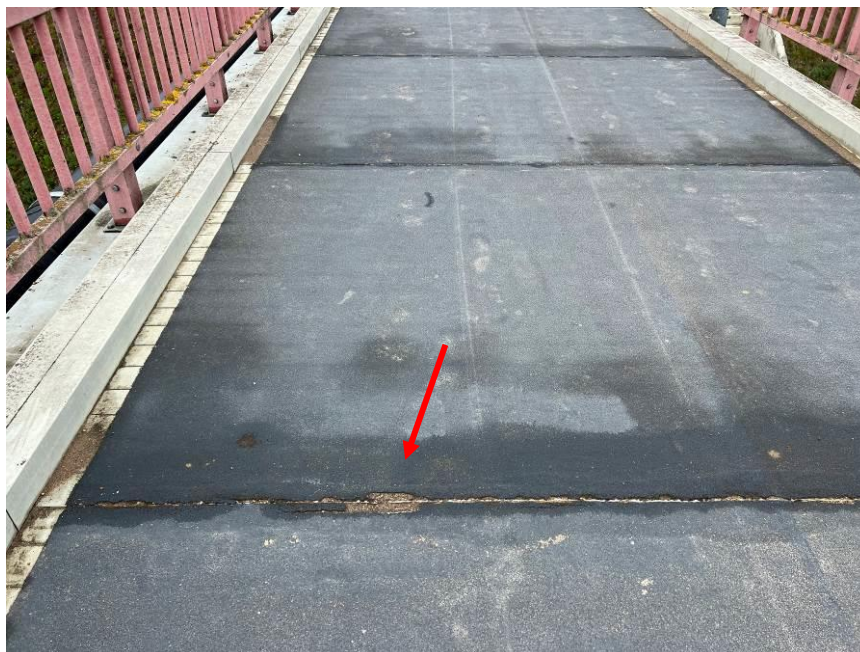
4.att. Šuvju vietās lobās ietves segums. Sanesumi uz malām. Skats uz tilta brauktuvi 3.laidumā.
