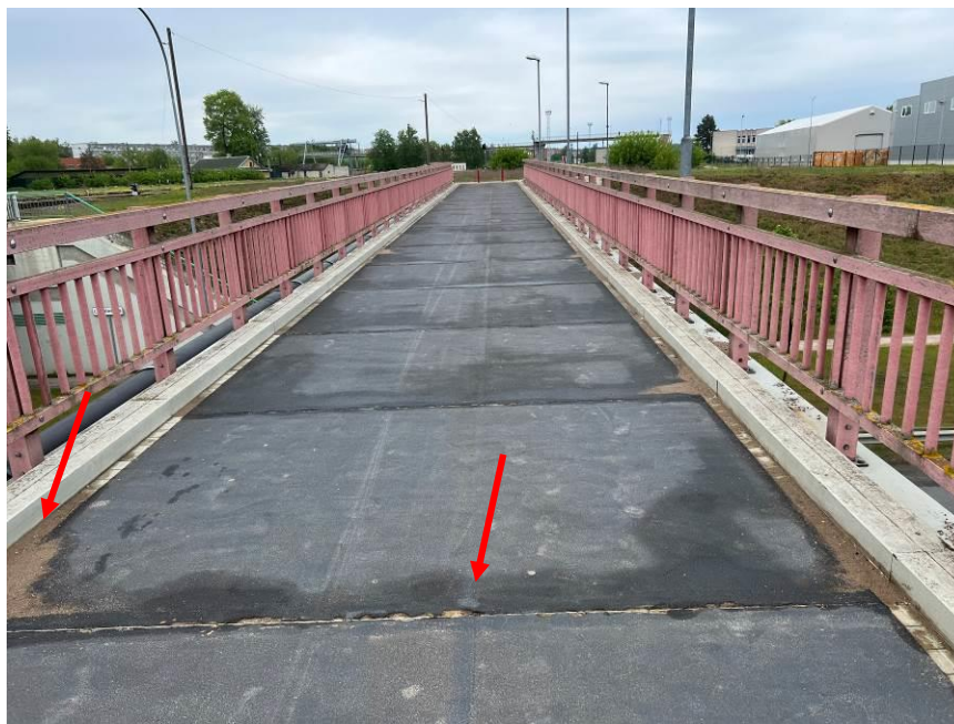
5.att. Šuvju vietās lobās ietves segums. Sanesumi uz malām. Skats uz tilta brauktuvi 1.laidumā.
