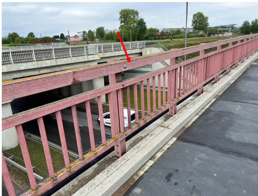
7.att. Izbalējis un apaudzis margu krāsojums. Skats uz tilta margām (Piekrastes ielas puse).
