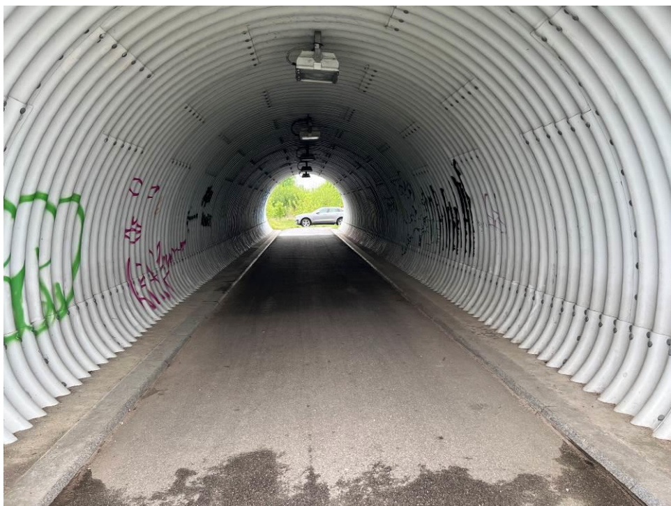
6.att. Skats tunelī Latgales ielas puse.
