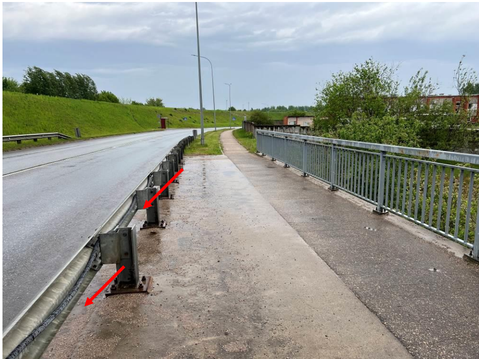
16.att. Elektrokabelis stiprināts pie barjeru konstrukcijas.
