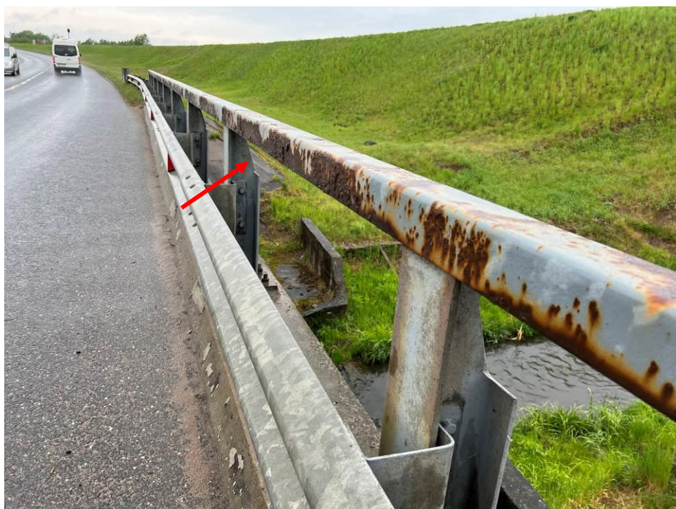
8.att. Korodē barjeru konstrukcijas rokturis un skrūves. Skats augšteces pusē.
