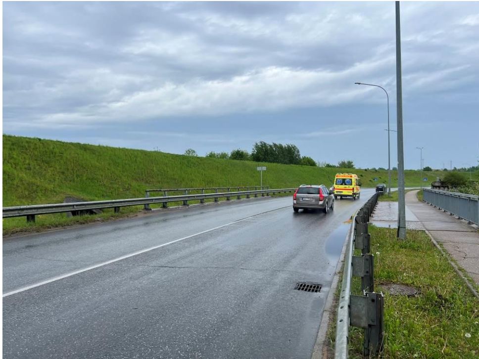
1.att. Tilta brauktuve. Skats no Kraujas ielas puses.
