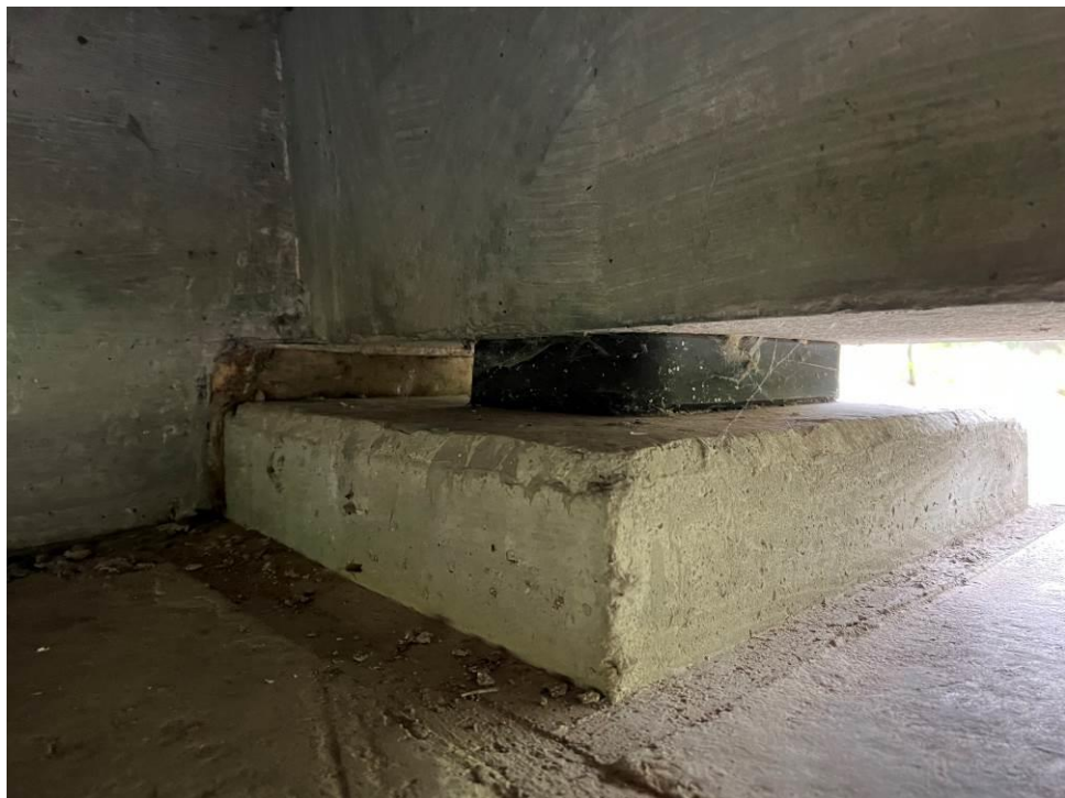
14.att. Skats uz uzkalu un balstīklām virs krasta balsta Nr.2.
