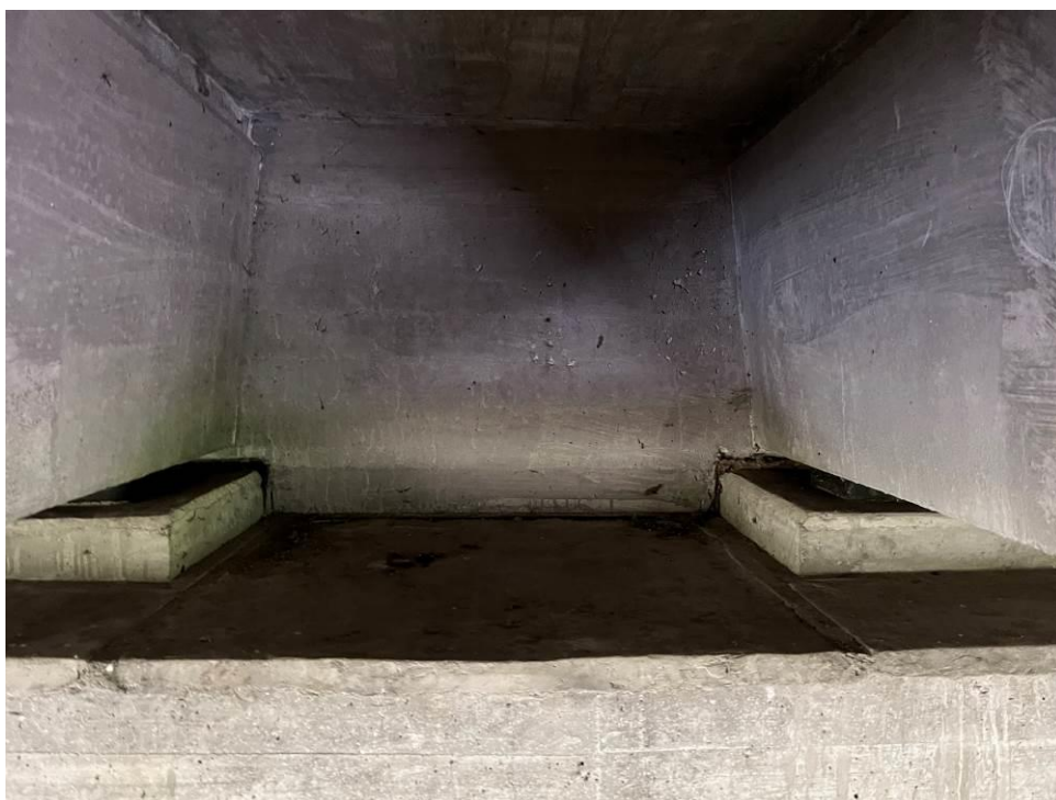
12.att. Skats uz uzkalu un balstīklām virs krasta balsta Nr.1.
