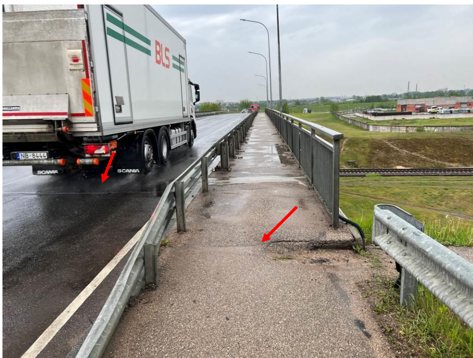
27.att. Iesēdums segumā pieejā ietves daļā. Skats pie krasta balsta Nr.5
