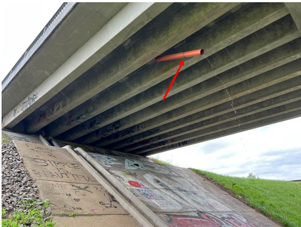
25.att. Virsmas ūdens no brauktuves novadīts no liela augstuma. Skats pie krasta balsta Nr.5.
