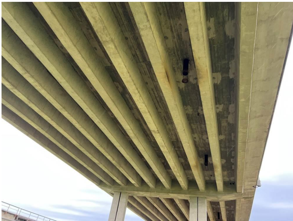
14.att. Skats uz 3.laidumu no apakšas.
