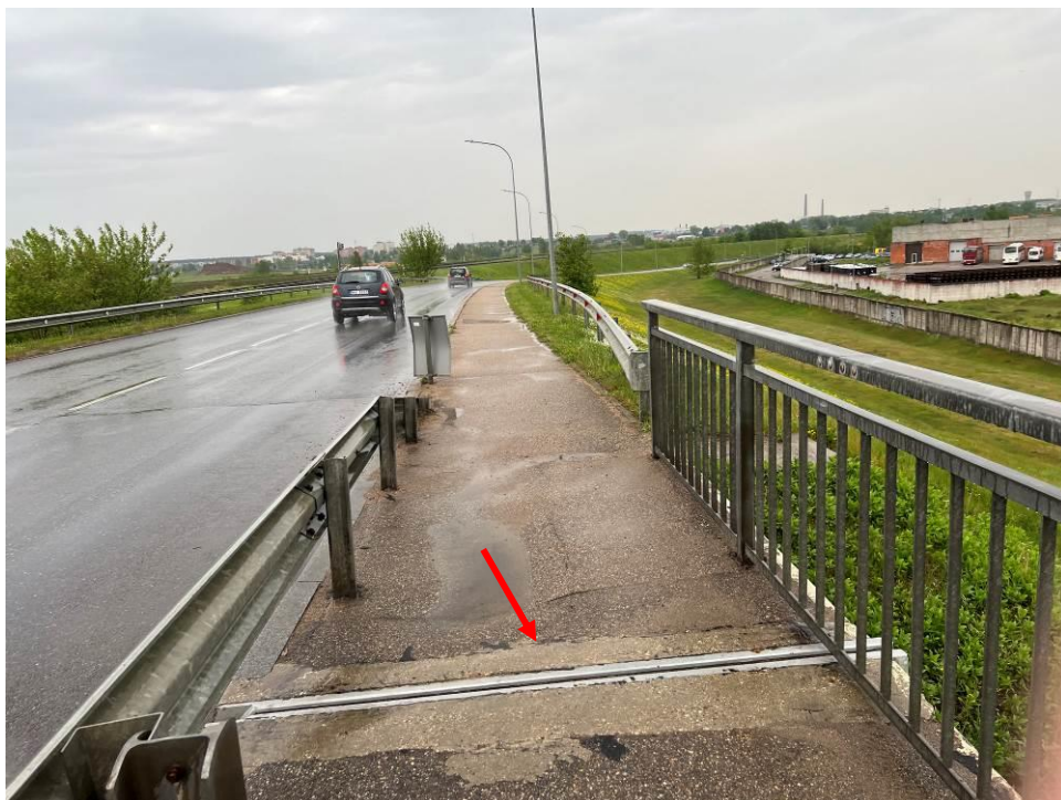
7.att. Skats uz deformācijas šuvi ietves daļā virs krasta balsta Nr.1.
