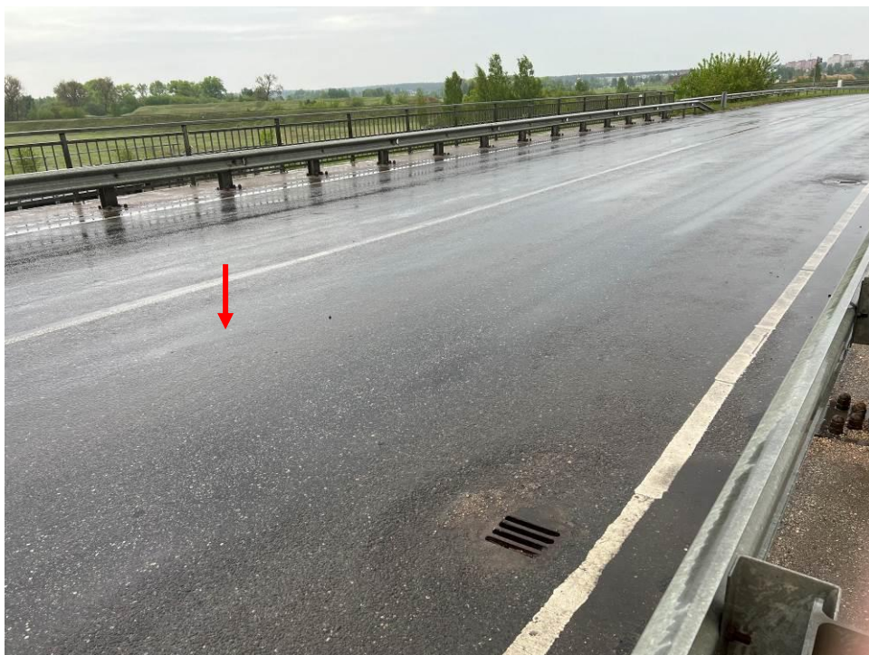
3.att. Skats uz tilta brauktuvi 3.laidumā.
