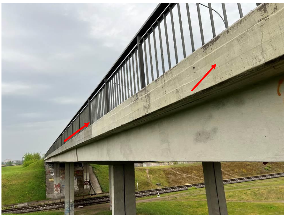
12.att. Mikroplaisas ietves konsolē. Skats pie starpbalsta Nr. 4 dz/c pusē.
