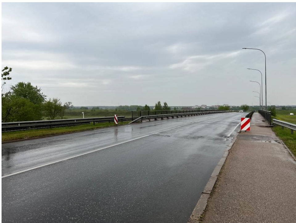
1.att. Tilta brauktuve no DEPO puse.
