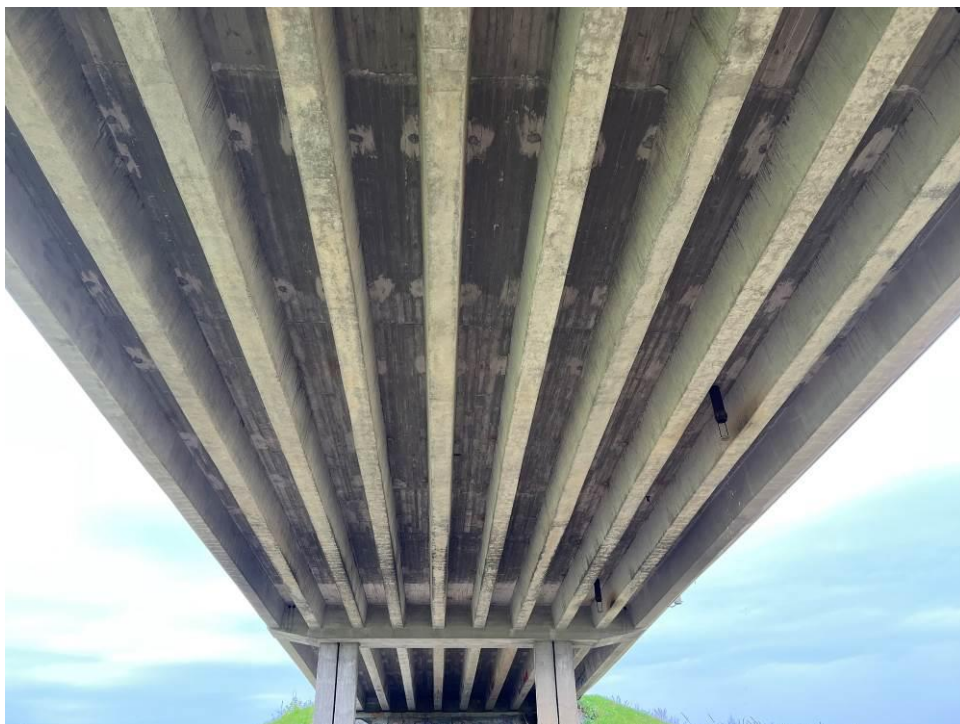
15.att. Skats uz 2.laidumu no apakšas.
