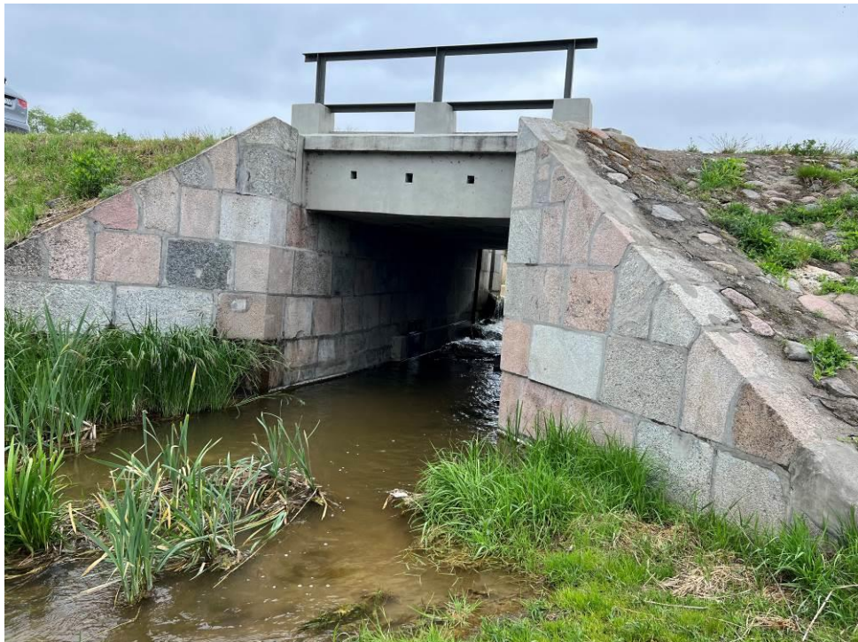
2.att.Tilta sānskats no lejteces puses.
