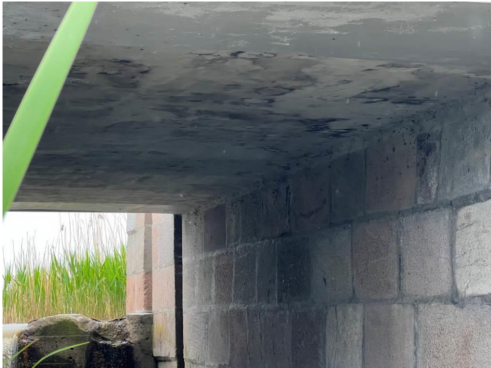
7.att. Skats uz laiduma konstrukciju no apakšas.
