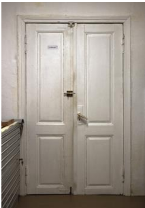
Pilnā komplektācijā saglabājušās divviru rāmja-pildīna konstrukcijas sākotnējās durvis D1-5 starp telpām nr. 1-5 un nr.1-6 . 2024. g. foto
