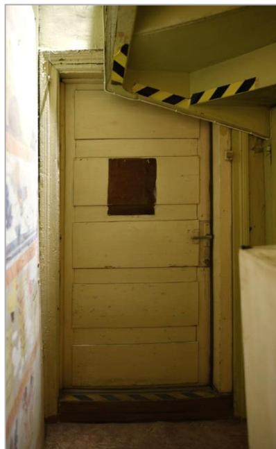
Tipiska 20. gs. 50. gadu vai 60. gadu sākuma iekšdurvju vērtne D1-2 ar 5 pildiņiem ēkas Z korpusa 1. stāvā. 2024. g. foto
