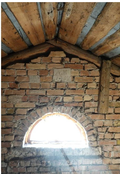
Uz ēkas pamatkorpusa R puses mezonīna frontona daļas iekšpusē, bēniņu pusē, atstātie uzraksti: "AH 1907", "I(?) B 1921", "Ručins (?)", "10/ 1979" un "10. IX. 29. 1989".
