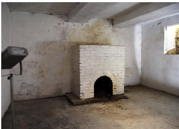
No neapmestiem ķieģeļiem būvētais kamīns pagrabstāva 2025.g. foto
