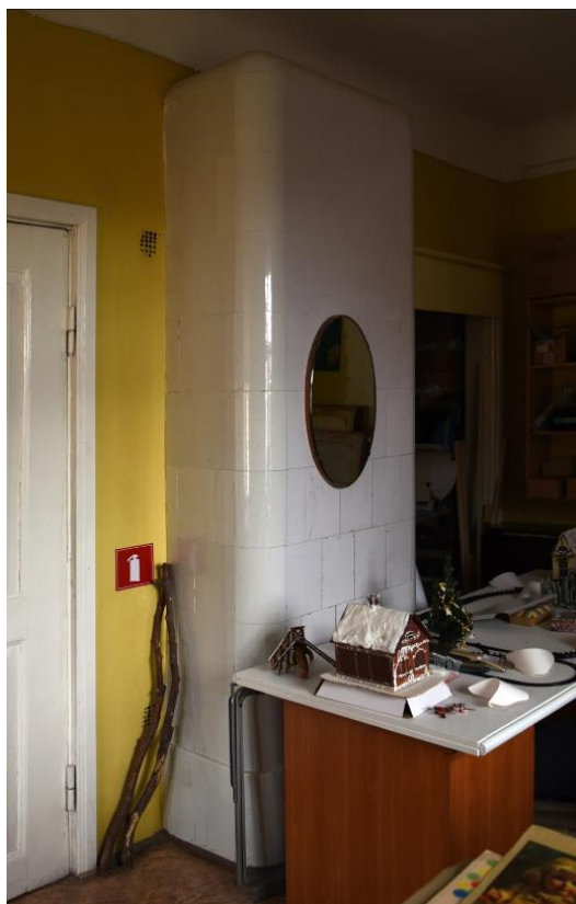
20. gs. 30. gadu podiņu krāsns telpā nr. 2-12, kas mūrēta no atšķirīgās nokrāsās balti glazētiem podiņiem. 2024. g. foto
