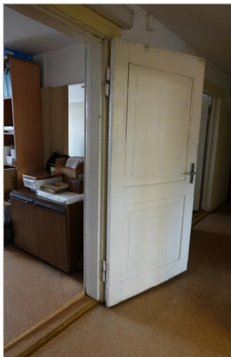
Ēkas trešajā stāvā, agrākajā viesnīcā, ap 1900. gadu ierīkotās durvīs D3-9, kuras padomju periodā – 20. gs. nogalē – papildinātas ar savā laikā izgatavotu šaurāku vērti (priekšplānā). 2024. g. foto.
