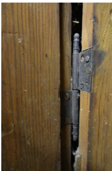
Pažobeles durtiņas un viena no pažobeles durtiņu stobrvirām. 2024. g. foto
