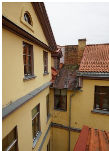
Skats uz D piebūves savienojumu ar A pamatkorpusu un šīs vietas jumtiņa skārda segumu. 2024. g. foto.
