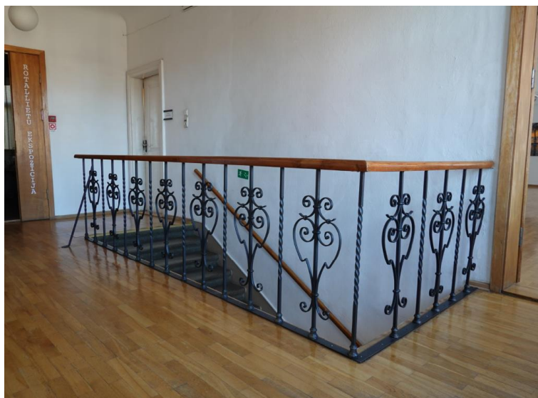
Skats uz betona kāpņu vietu ēkas otrā stāva līmenī (telpā nr.2-19), kur aizsardzībai no iespējamā iekrišana kāpņu šahtā izbūvētas margas ar dekoratīvi kaltiem reliņiem.
