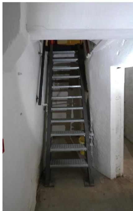
Mūsdienu kāpnes ar presēta skārda pakāpieniem, kas iebūvētas satrunējušu vecāku kāpņu vietā. 2025. gada foto
