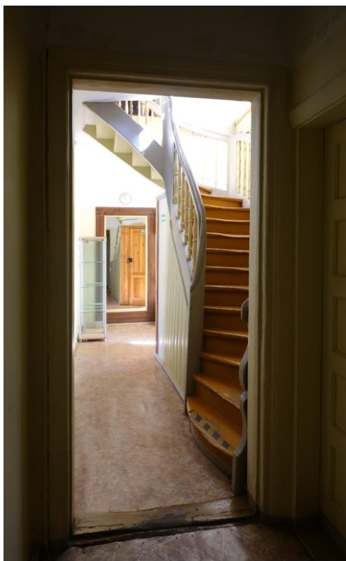
Skats uz 20. gs. sākumā iebūvētajām kāpnēm no otrā uz trešo stāvu no telpas nr.2-1 2024. gada foto.
