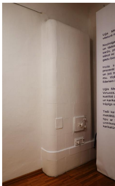
Neglazētu podiņu krāsns aizmugure telpā 2-21 un krāsns telpā nr.2-13. 2024. g. foto
