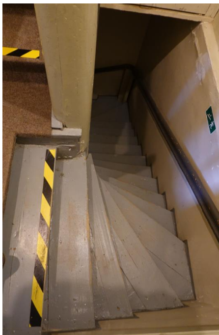
Koka kāpnes no ēkas otrā stāva uz pirmo telpā nr. 2-27. 2025. gada foto
