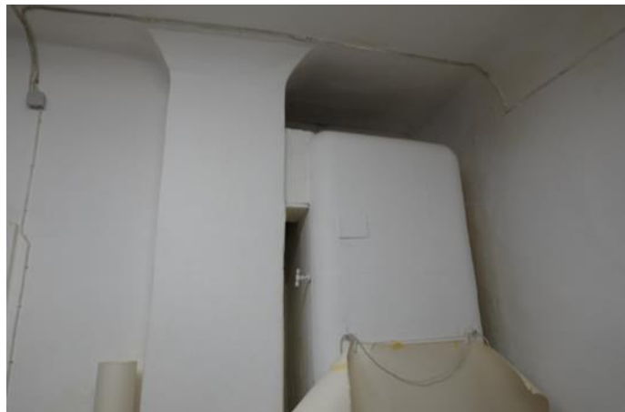
Neglazētu podiņu krāsns telpā nr.1-xx. 2025.g. foto
