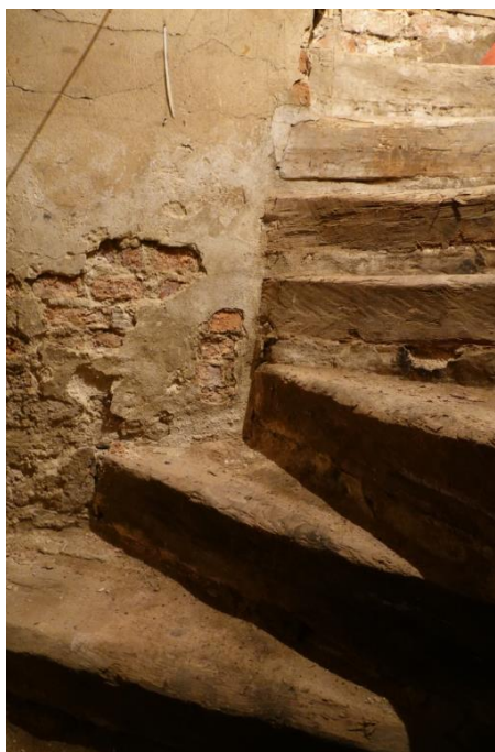
No koka brūsiņām būvēto pagrabu kāpņu pakāpieni no telpas nr.1-xx uz pagrabtelpu nr. Z spārnā, un vienā no brūsiņām redzamā ietapojuma vieta, kas norāda, ka tā ir kādas vecākas koka konstrukcijas daļa. 2024. gada foto
