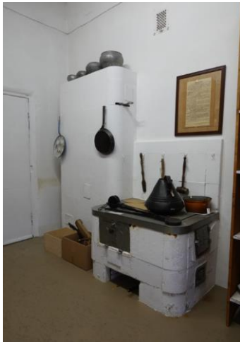
Neglazētu podiņu plīts ar sidmūrīti, kā arī krāsns aizmugure telpā nr.1-xx. 2025.g. foto
