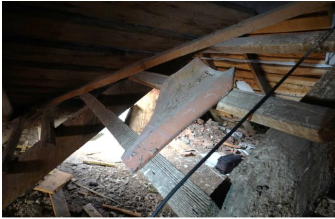
Vēlāk izbūvētā mezonīna bēniņu telpā saglabājušās sākotnējā jumta spāres un uz tām uzstādītās latas, kā arī viens uz latām palicis sākotnējais dakstiņš. 2025. g. foto
