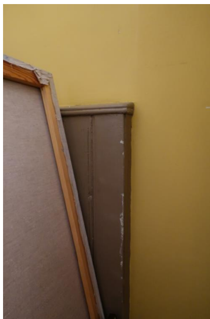
Sienas paneļa fragments ēkas 2.stāvā, kādreizējās viesu telpās (telpa nr. 2-11). 2024. g. foto
