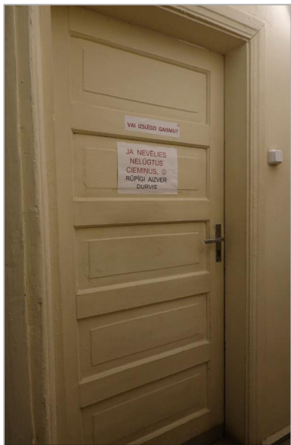
Tipiska 20. gs. 50. gadu vai 60. gadu sākuma iekšdurvju vērtne D2-7 ar 5 pildiņiem ēkas Z korpusa 2. stāvā. 2024. g. foto
