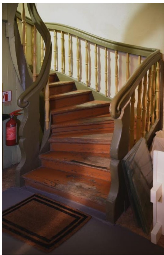
Sākotnējās 1880. gadu kāpnes ēkas Z spārnā tā pirmā stāva līmenī. 2025. gada foto.
