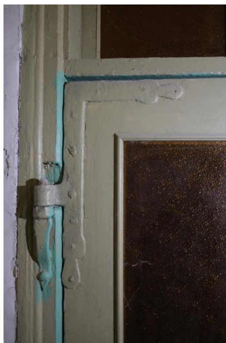
Viena no pagalma ārdurvju sākotnējām, iespējams, 1880. gadu kalējkaltajām virām, iekārta sākotnējā viras kāsi. 2024. gada foto
