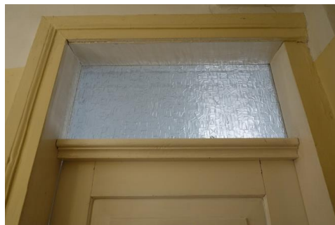
Augšējā attēlā: vienu vēsturisko vienas vērtne durvju aila D2-9 ar padomju laikā nomainītu vērtni un virsgaismas daļu, taču saglabājušos virsgaismu nodalošo šķērsi. 2024. g. foto
