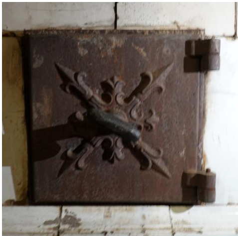
20. gs. Sākuma krāsns sākotnējās čuguna lējuma durtiņas (ārējās un iekšējās). 2024. g. foto
