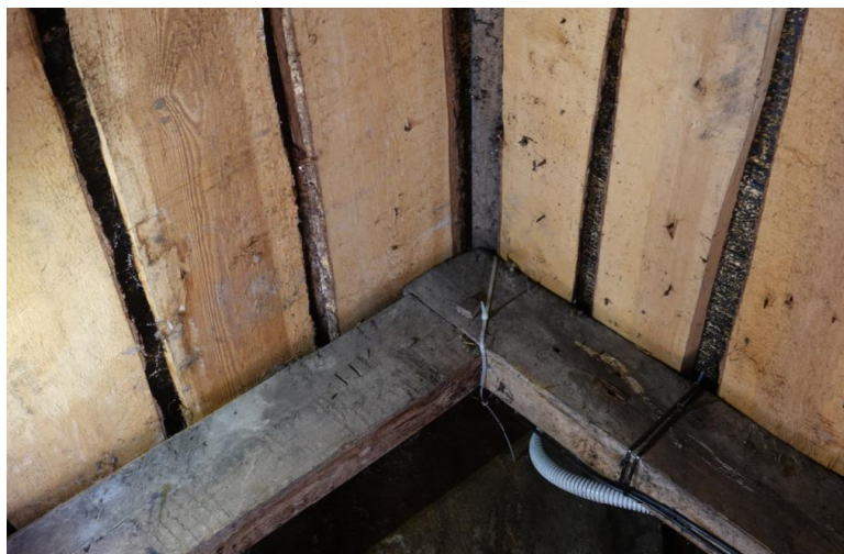
Ar romiešu ciparu III marķētu spāru pāru savienojuma vieta jumta korē. 2025. g. foto
