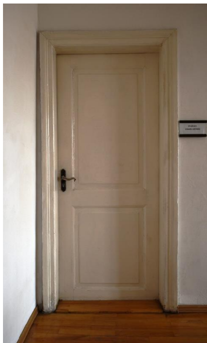
Ap 1900. gadu izgatavotās un uzstādītās durvis D2-17 starp telpām nr. 2-19 un nr. 2-17. 2024. g. foto
