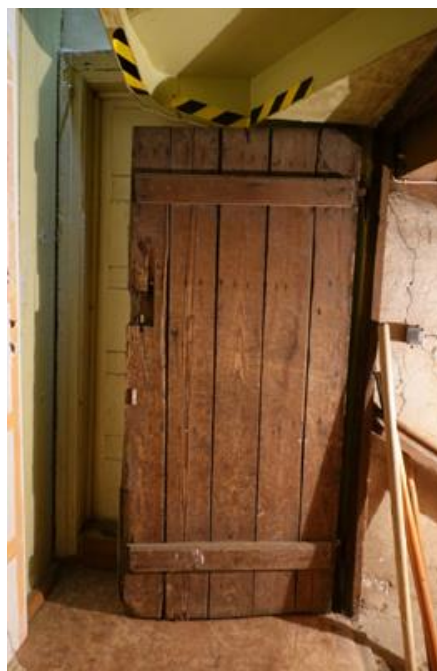
Vienkārsa dizaina tā sauktās “dēļu durvis” D1-3 noejai uz pagrabu celtnes Z spārnā. 2025. g. foto
