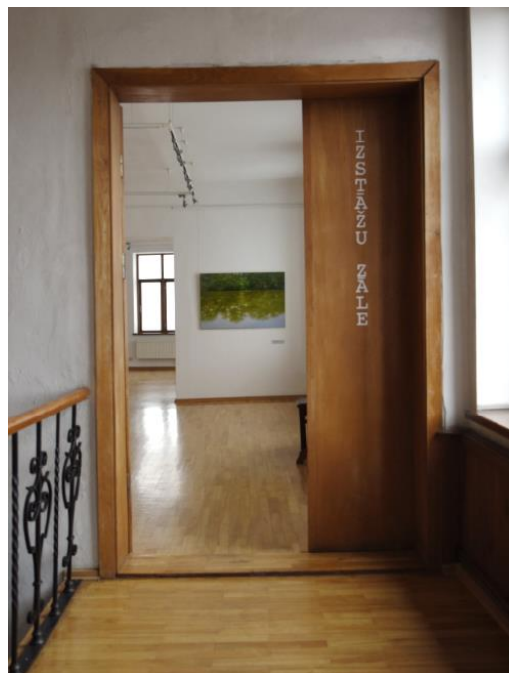
20. gs. 70. gadu vidū izgatavotās divviru iekšdurvis D2-16 ar asimetriskām vērtņēm. 2024. g. foto
