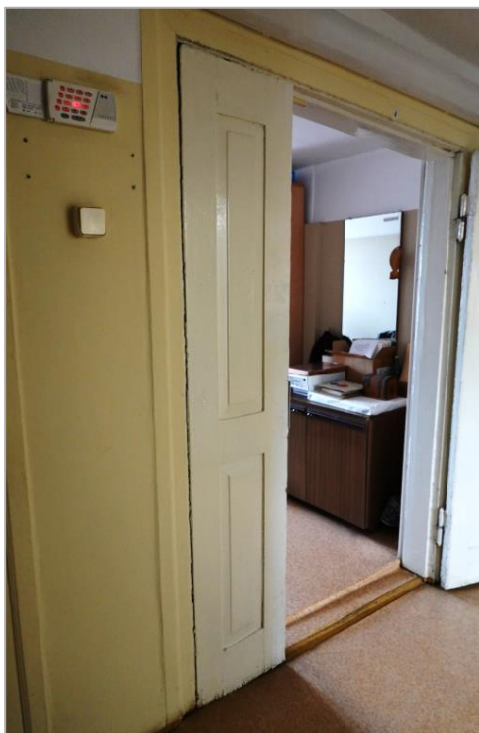
Ēkas trešajā stāvā, agrākajā viesnīcā, ap 1900. gadu ierīkotās durvīs D3-9, kuras padomju periodā – 20. gs. nogalē – papildinātas ar savā laikā izgatavotu šaurāku vērti (priekšplānā). 2024. g. foto.
