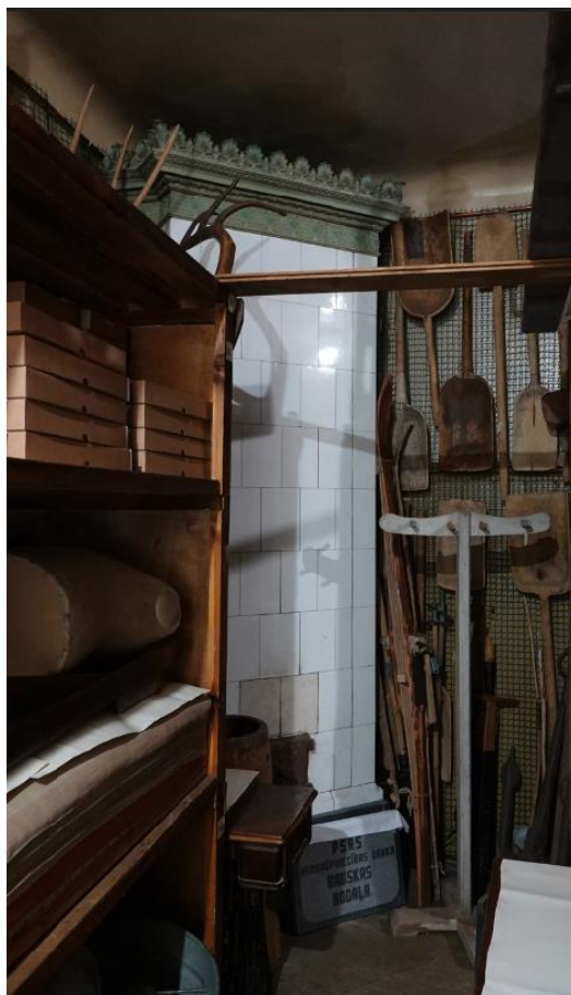
Balti glazētu podiņu krāsns ar zaļi glazētu augšdaļu telpā nr.XX. 2024. g. foto
