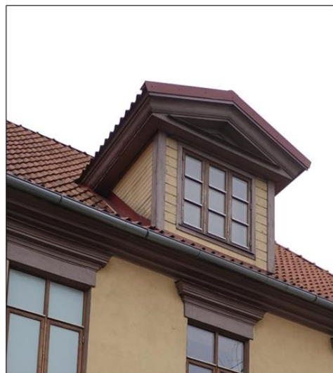
Lukarna pēc tās detaļu vienkāršošanas jumta seguma maiņa laikā. 2024. g. foto
