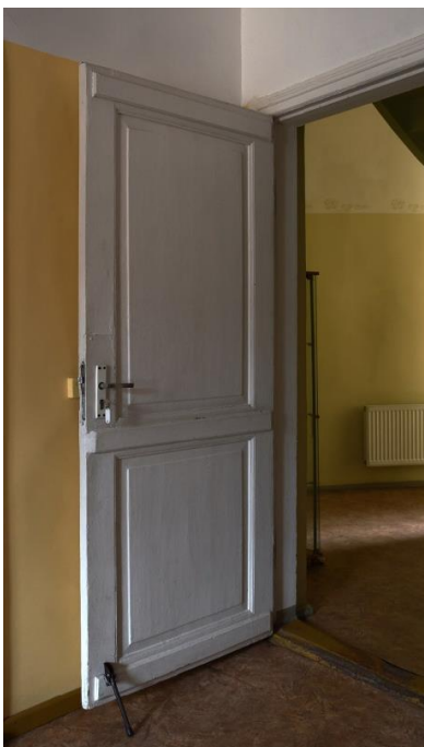
Ap 1900. gadu izgatavotās un uzstādītās durvis D2-13 starp telpām nr. 2-1 un nr. 2-12. 2024. g. foto
