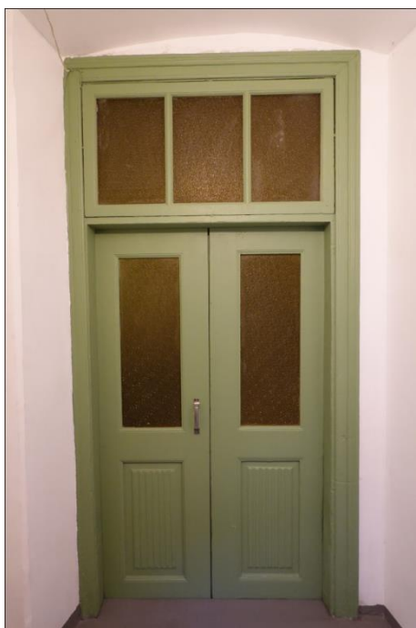
20. gs. sākumā iebūvētās pagalma puses ieejas durvis ar jaunāka laika stiklojumu un sākotnējo virsgaismu. 2024. gada foto
