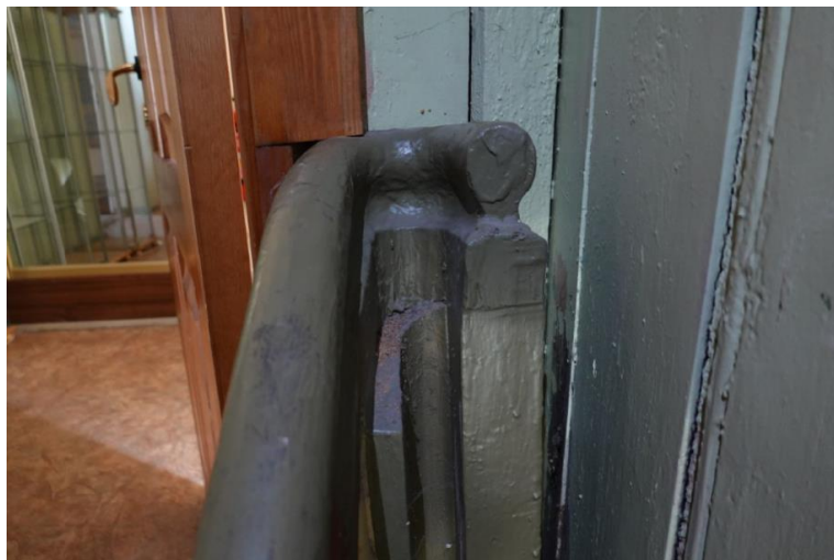
No pirmā uz otro stāvu vedošo kāpņu augšējā statņa augšdaļa, kuras nocirtums skaidri norāda un to, ka sākotnēji kāpnes norobežojošās sieniņas vietā bija izbūvēts horizontāli orientēts margu turpinājums. Sakarā ar kāpņu atvēruma aizdēlošanu, margas likvidētas, to turpinājumu robusti nošķēlot. 2024. gada foto
