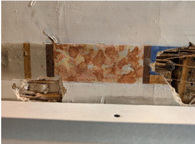
Ēkas pirmā stāva telpā nr.1-11 remontdarbu laikā atklātās griestus apdares fragments. 2025.g. foto
