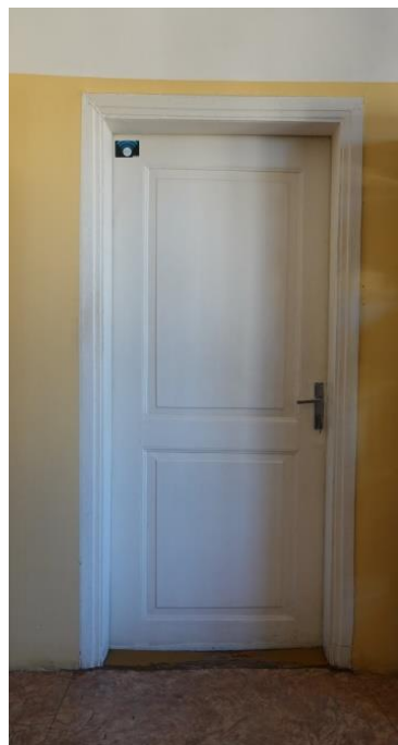
Ap 1900. gadu izgatavotās un uzstādītās durvis D2-12 starp telpām nr. 2-11 un nr. 2-12. 2024. g. foto
