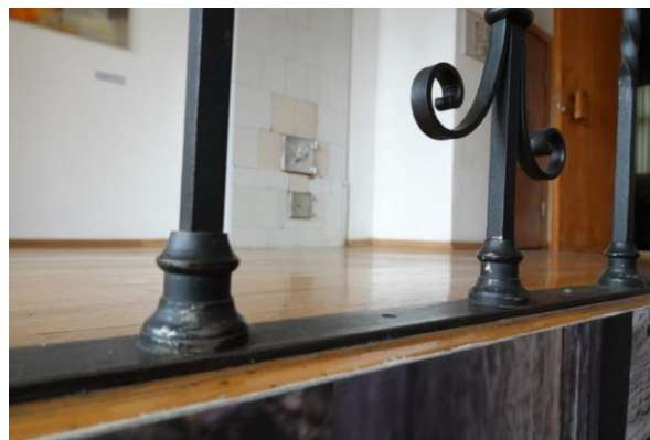
No jauna darināto reliņu statņu virpotie apakšdaļas elementi stiprināti pie metāla slīdes 2. stāva grīdas līmenī. 2024. gada foto
