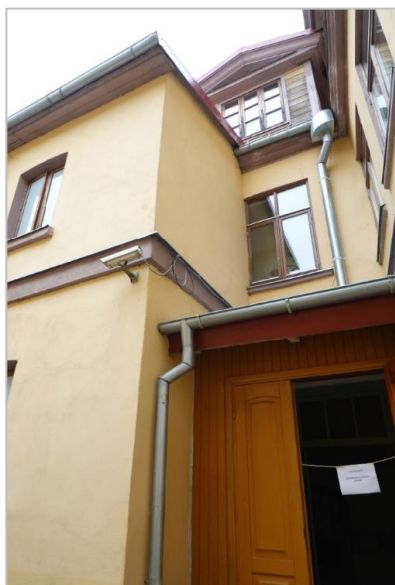
20. gs. sākumā iebūvētās pagalma puses ieejas durvis ar jaunāka laika stiklojumu un sākotnējo virsgaismu. 2024. gada foto
