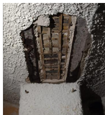
Vieta, kur paralēli uzstādītas divas velves balstošās metāla sijas un starp tām iebūvēta koka sija ar skaliņiem apmetuma stiprināšanai. 2025. gada foto
