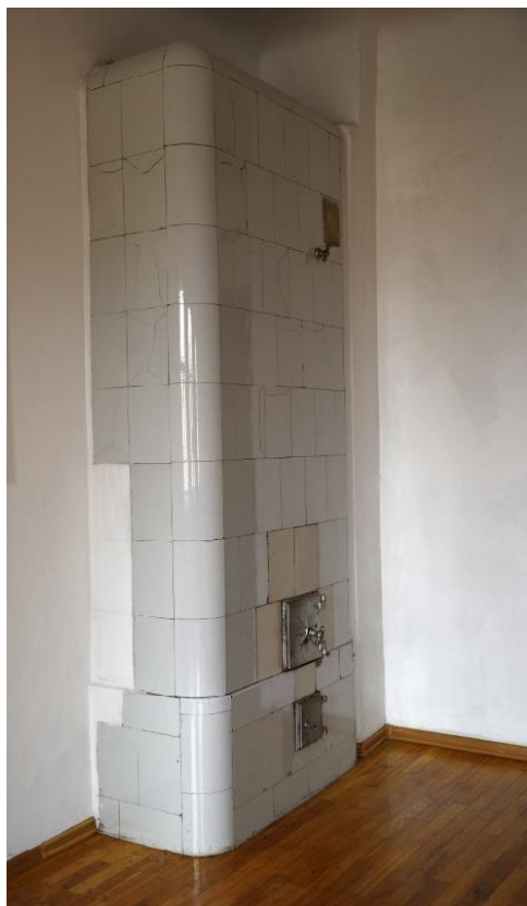
20. gs. 30. gadu podiņu krāsns telpā nr. 2-19, kas mūrēta no atšķirīgās nokrāsās balti glazētiem podiņiem. 2024. g. foto
