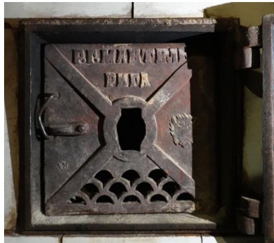
20. gs. Sākuma krāsns sākotnējās čuguna lējuma durtiņas (ārējās un iekšējās). 2024. g. foto
