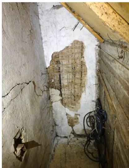
Skats vienā no ēkas pažobelēm, kur uz koka planku iekšsienas apmetuma nobiruma vietā labi redzams zem tā stiprinātais niedru klājs. 202.. g. foto
