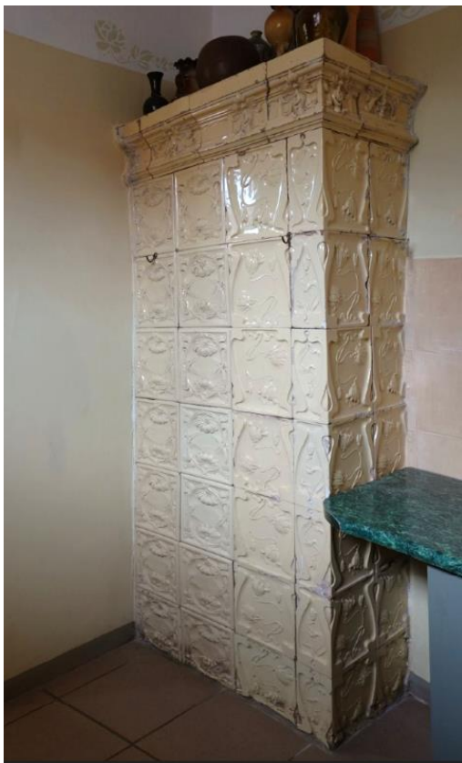
Krāsns telpā nr. 2-5, kas uzmūrēta no fabrikā “Zelm & Boehm” ražotiem un telpā nr. 2-17. sākotnēji iebūvētas krāsns podiņiem. Daļa podiņu zuduši. 2024. g. foto
