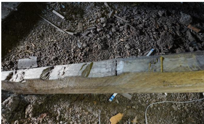
Viena no mezonīna daļā palikušajām sākotnējā jumta slīpnes spārēm ar iecirtumiem latu izlīdzināšanai. 2025. g. foto
