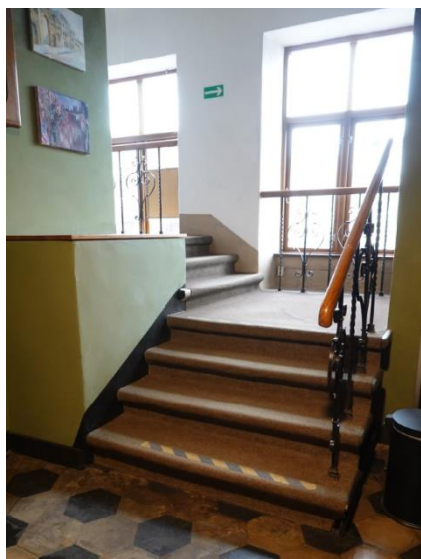
Skats uz 20. gadsimta sākumā iebūvēto betona kāpņu apakšējo laidu un pirmo kāpņu laukumiņu no muzeja ieejas vestibila puses.
