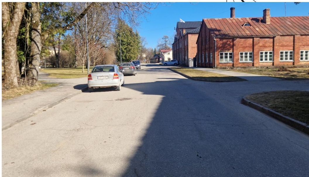
Skats Pk 2+20, virzienā uz Rīgas ielu.
