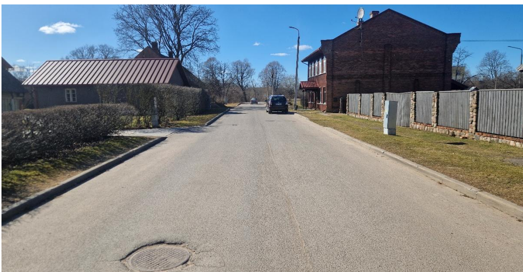
Skats Pk 1+00, virzienā uz Īso ielu.
