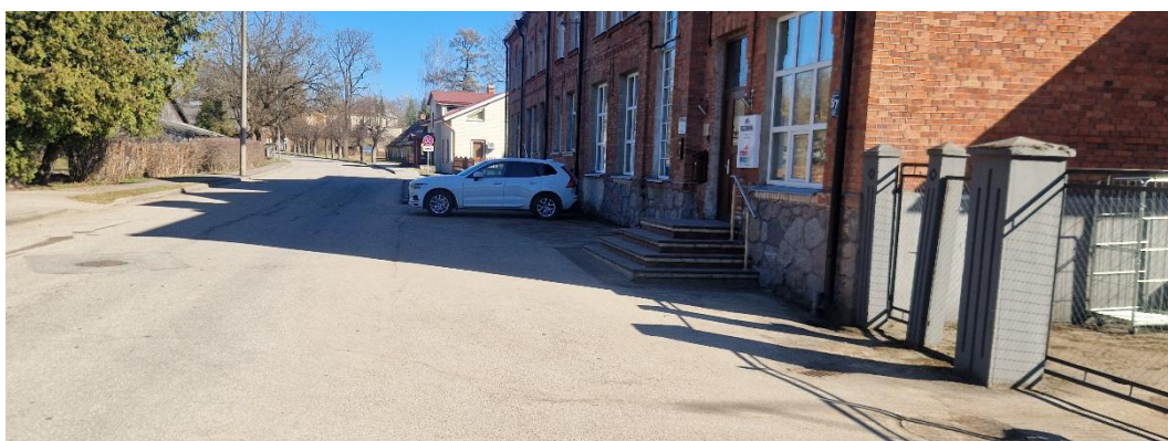
Skats Pk 2+80, virzienā uz Rīgas ielu.
