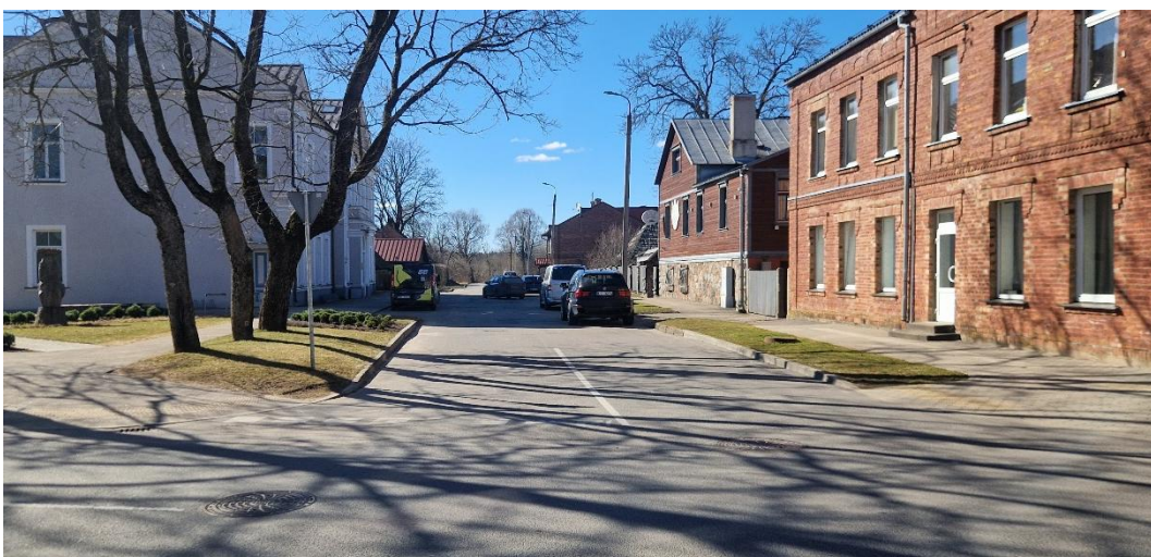
Skats Pk 2+00, virzienā uz Īso ielu.
