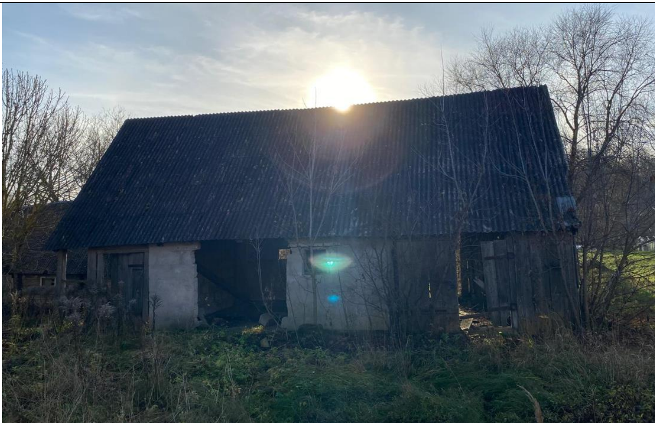
Foto 4.19.1 Skats no priekšas fasādes
