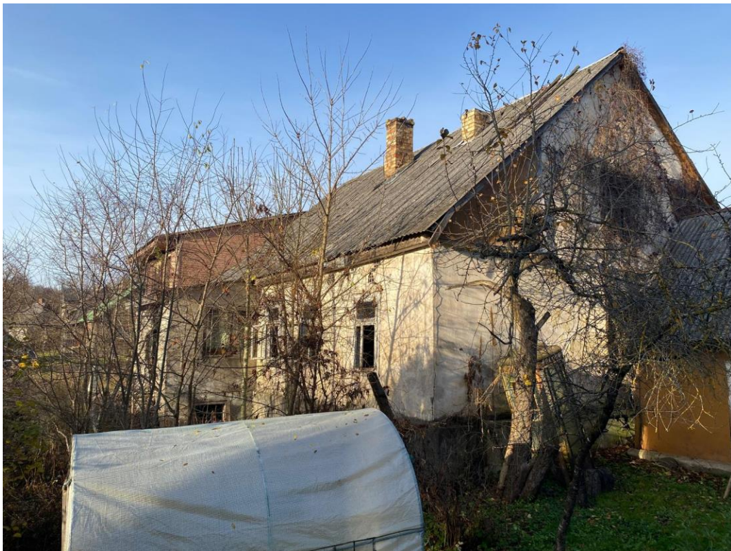
4.att. Demontējamās dzīvojamās mājas kopskats no DA puses.
