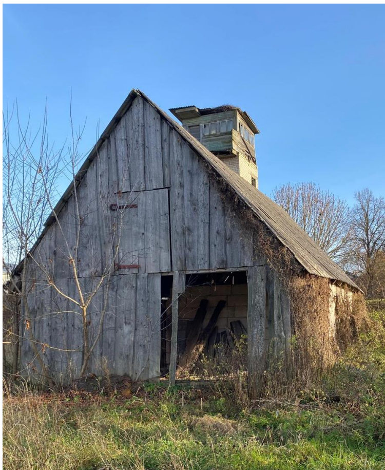
1.att. Demontējamās saimniecības ēkas kopskats no DA puses.
