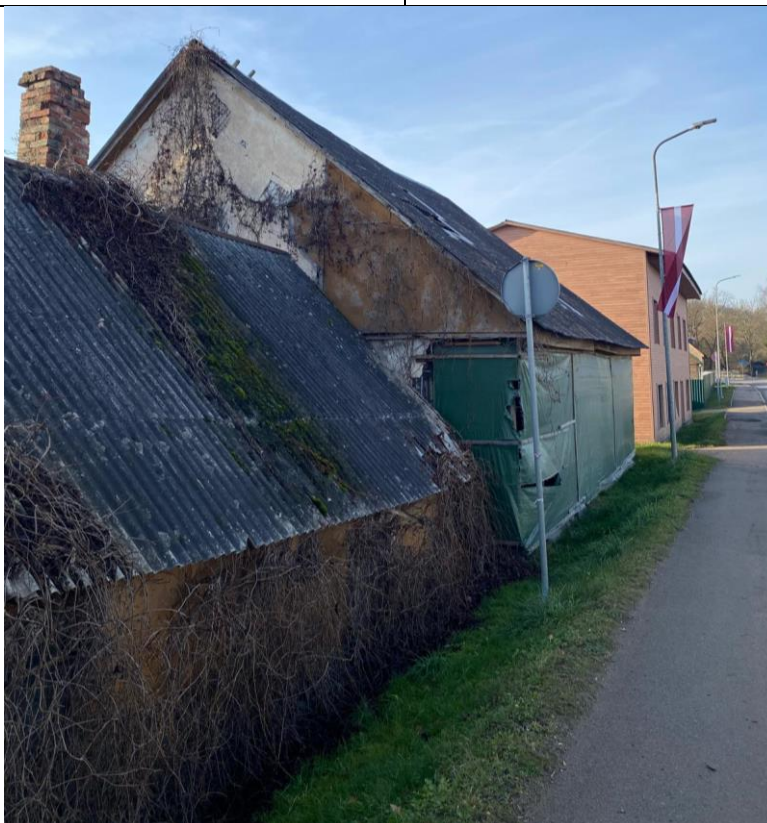
1.att. Demontējamās dzīvojamās mājas kopskats no ZA puses.
