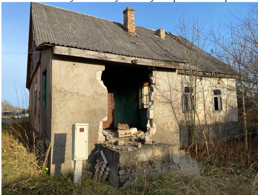
2.att. Demontējamās dzīvojamās mājas kopskats no R puses.
