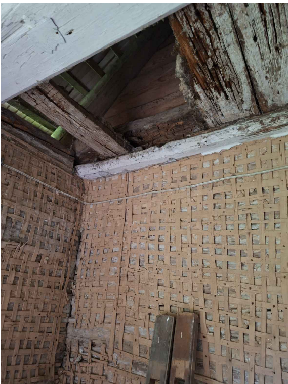
Skats uz bojāto pārseguma fragmentu no pirmā stāva telpas. Redzami satrupējuši griestu dēļi.
