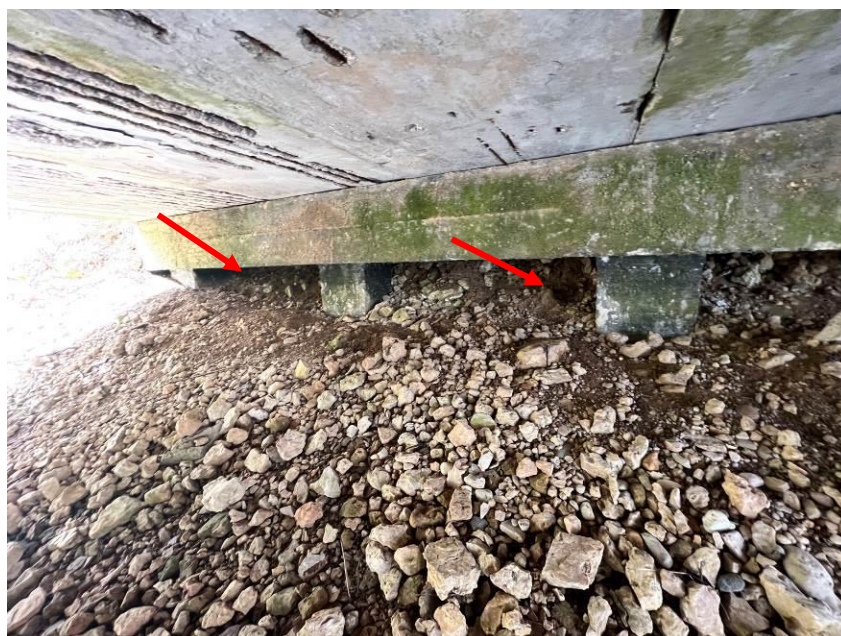
10.att. Trūkst konusa nostiprinājums, tukšumi zem uzkalas Skats uz krasta balstu Nr.1.
