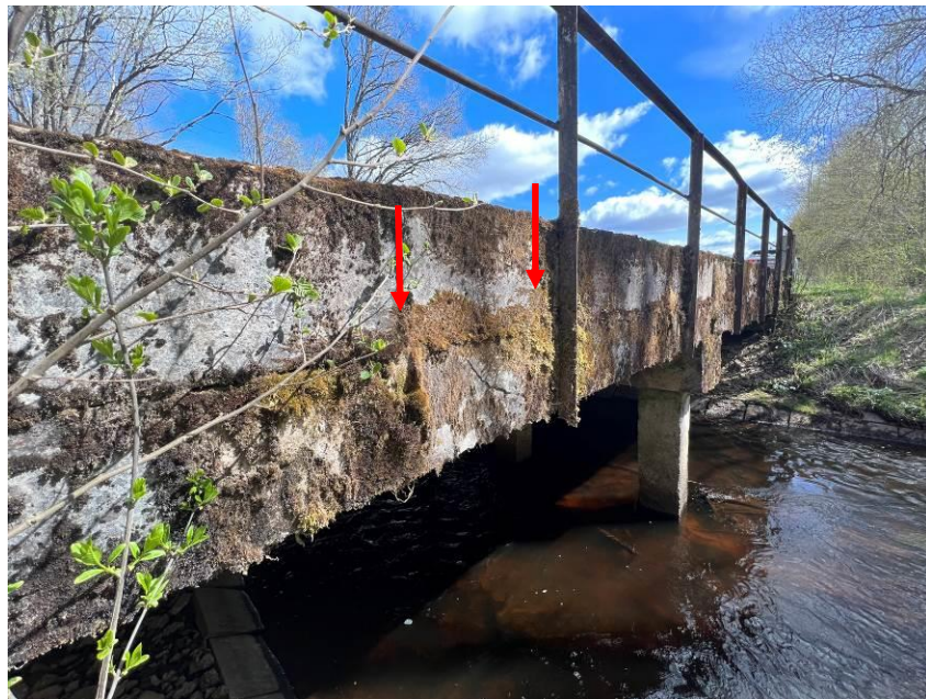
13.att. Aaugums uz tilta konstrukcijām. Skats lejtecē pusē.
