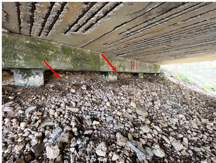
9.att. Trūkst konusa nostiprinājums, tukšumi zem uzkalas Skats uz krasta balstu Nr.3.
