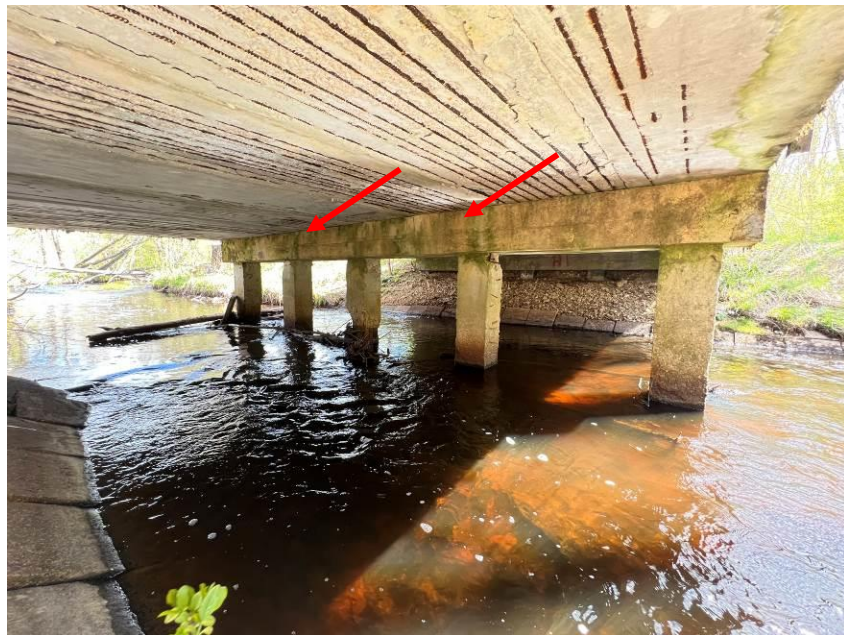
5.att. Ūdens tek cauri deformācijas šuve. Skats uz upes balstu Nr.2.
