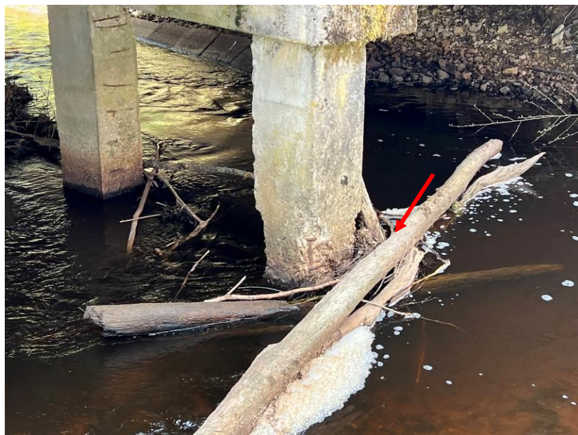
14.att. Sanesumi pie upes balsta. Skats uz upes balstu Nr.2 augštecē.
