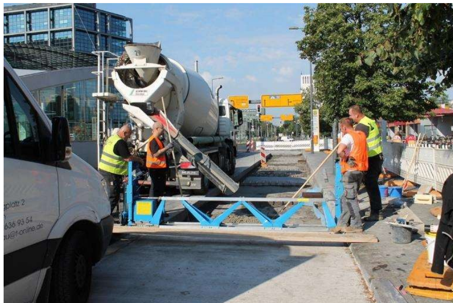
4. att. Piemērs – Betona iestrāde ar vibrolatu
