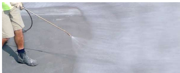
8.att. Piemērs – apstrāde ar pretizzūšanas sastāvu
