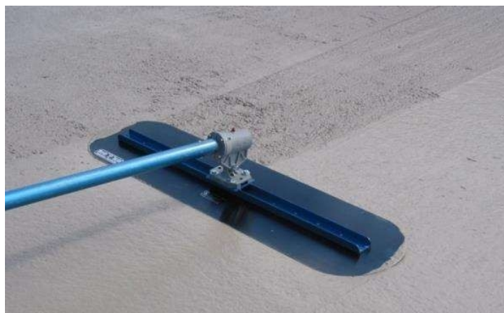
5. att. Piemērs – Betona virsmas līdzināšana ar peldošo izlīdzināmo dēli
