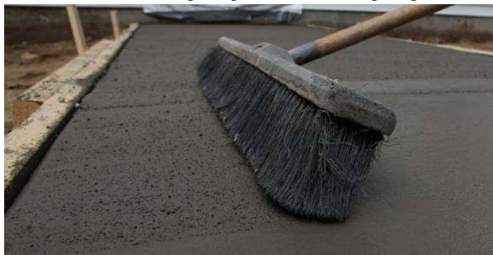
7. att. Piemērs – Ar birsti tiek ievilkta faktūra betona virsmā
