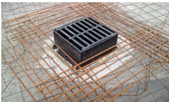
1. att. Piemērs – Stiegrojums ap gūliju
