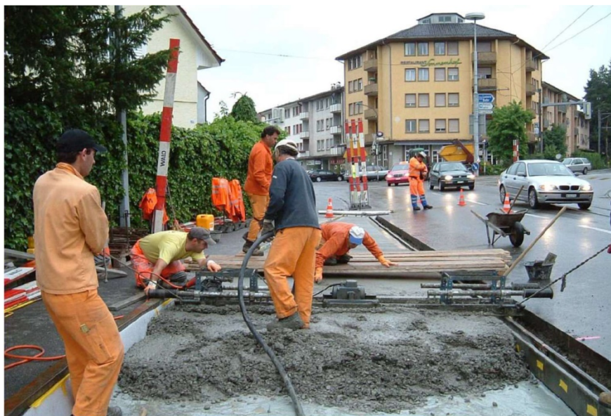
3. att. Piemērs – Betona iestrāde ar vibrolatu
