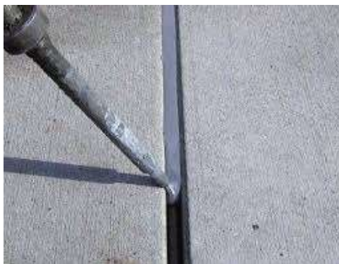
9. att. Piemērs – hermētiķa iepildīšana rukuma šuvē
