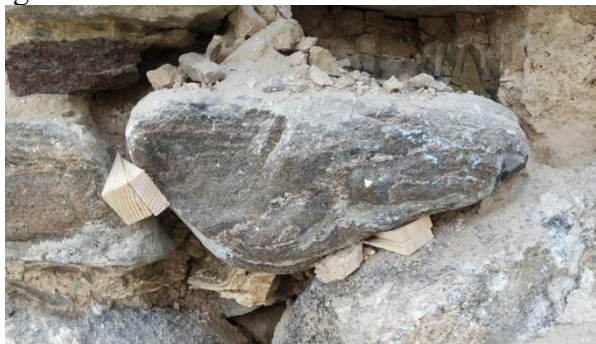
Piemērs nestabilo mūra akmeņu iekāļēšanai pirms mūra šuvju zudumu atjaunošanas
