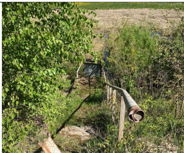
Attēls Nr.11 – Caurtekas-regulatora izplūdes bloks ar pakāpieniem un paceltu aizvaru, Pik. 14/00.
