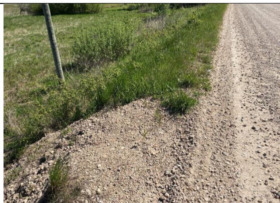
Attēls Nr.5 – Skats uz aizsargdambi Pik. 04/50. Labots ceļa nomales izskalojums
