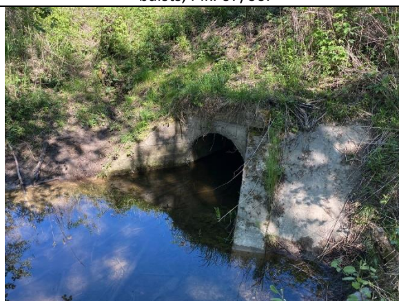
Attēls Nr.10 – Caurteka-regulators ūd.līm. dīķī regulēšanai, ieplūde, Pik. 14/00.
