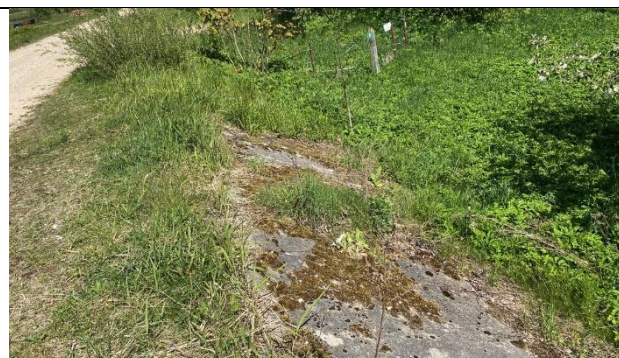
Attēls Nr.16 – Dzelzsbetona plātnes uz aizsargdambja slapjās (pret Lielupi vērstās) nogāzes Pik. 22/00.
