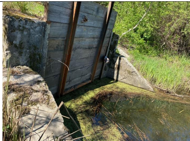
Attēls Nr.14 – Skats uz caurtekas-regulatora ieplūdes daļas aizvaru Pik. 17/75.
