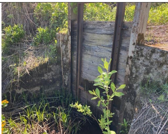
Attēls Nr.7. – Skats uz caurtekas-regulatora izplūdes daļas aizvaru Pik. 07/00.
