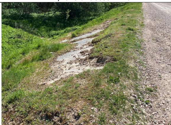
Attēls Nr.15 – Dzelzsbetona plātnes uz aizsargdambja slapjās (pret Lielupi vērstās) nogāzes Pik. 19/00.
