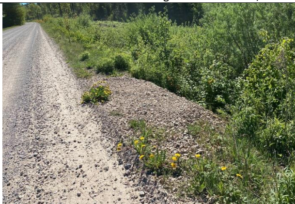
Attēls Nr.3 – Skats uz aizsargdambi Pik. 03/40. Labots ceļa nomales izskalojums
