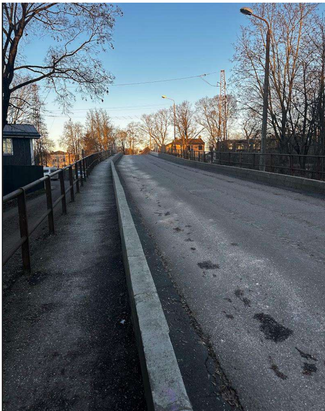
3. att. Skats uz pārvadu no Tēriņu ielas puses.
