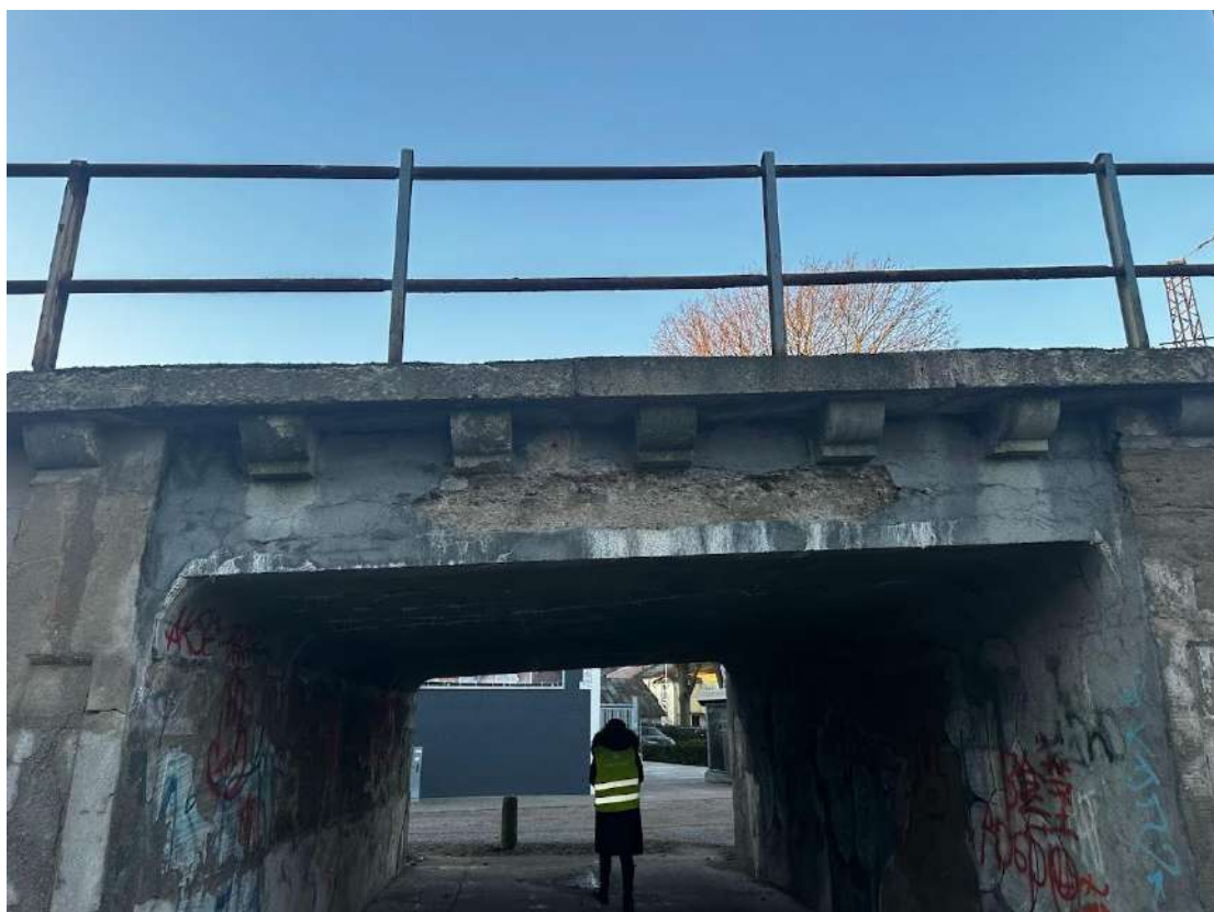
13. att. Skats uz gājēju tuneli no Grobiņas ielas.
