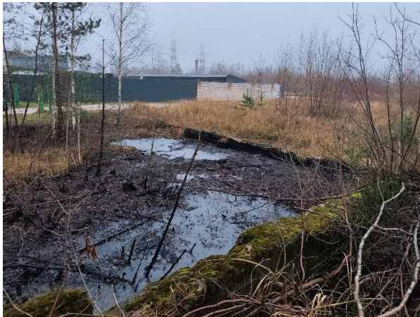
3. attēls. Bitumena tvertne (2025.gads)
