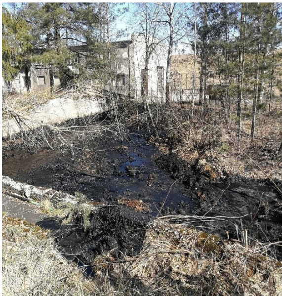
2. attēls Bitumena tvertne (2022.gads)
