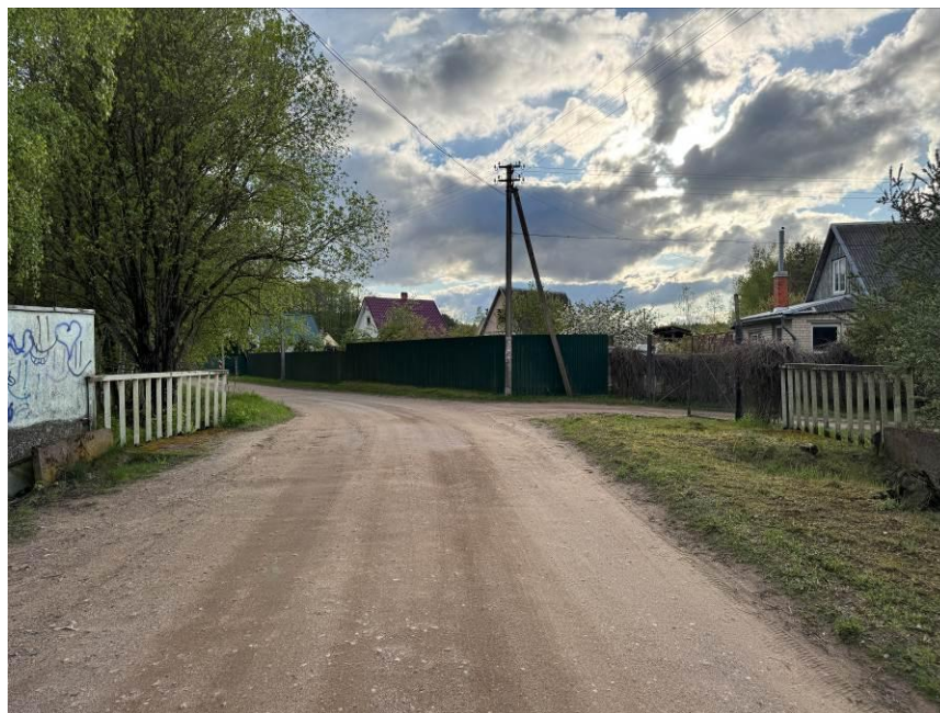
2.att. Brauktuve virs caurtekas no krasta balsta Nr.2 (Dravnieku iela)
