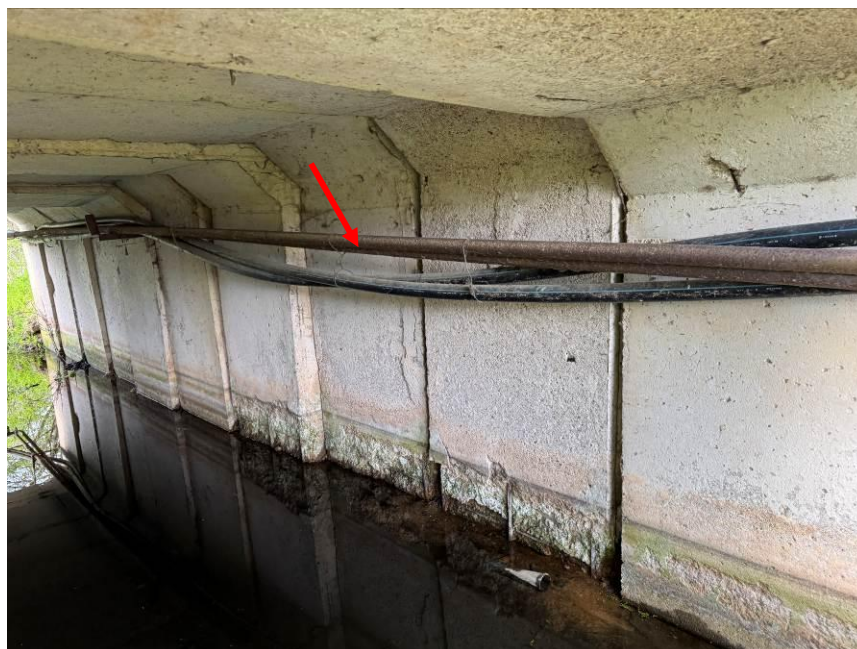
24.att. Komunikācijas uz tilta konstrukcijām. Skats uz krasta balsta Nr.2.
