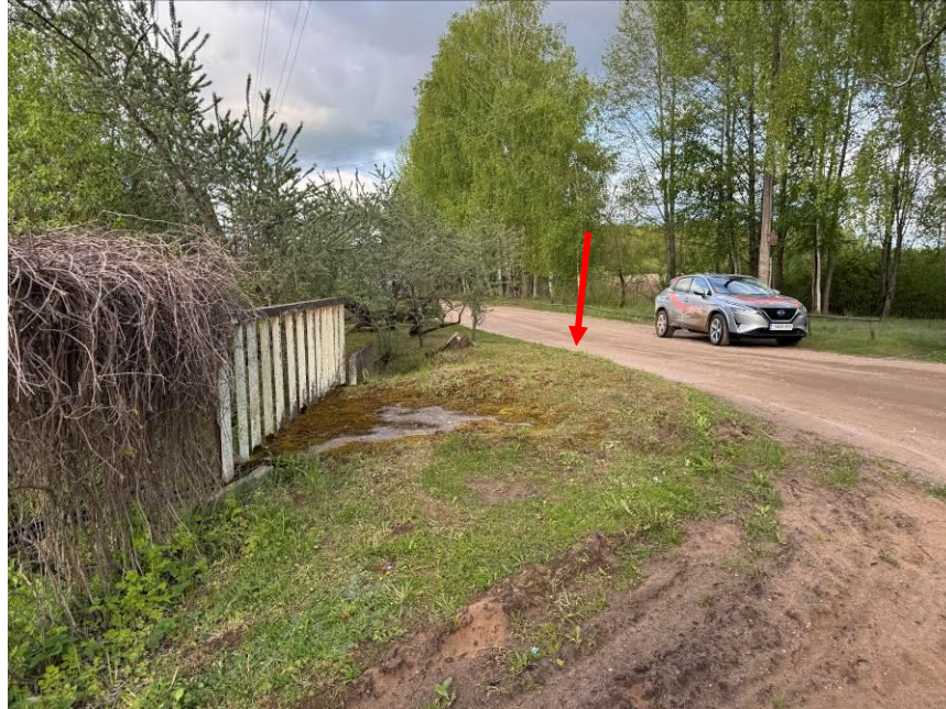
7.att. Brauktuves un ietves segumā apaugums. Skats uz brauktuvi un ietvi no krasta balsta Nr.1 puses augštecē.
