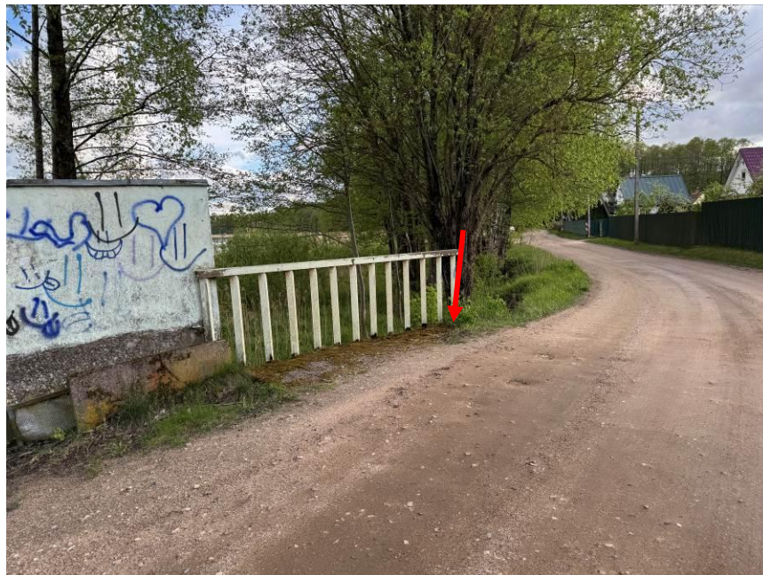
8.att Ietves segumā apaugums. Skats uz ietvi no krasta balsta Nr.2 puses lejtecē.
